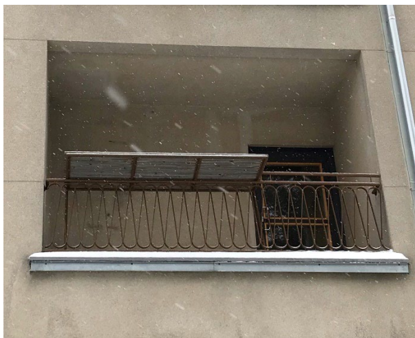
KUVA 9: Alavan sairaala, rakennus A1, osa 2 porraskäytävien parvekekaiteet (Rönkkö, 2022)
