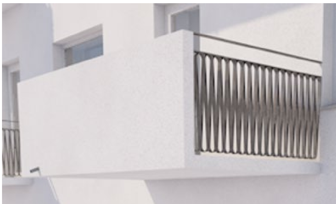
KUVA 21. Uusien sisäpihan puoleisten ulokeparvekkeiden sivukaiteet on suunniteltu muistuttamaan tuuletusparvekkeiden muotoiltuja teräspinnakaiteita
