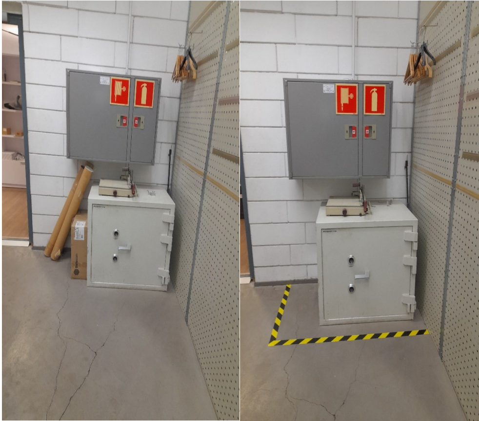
Kuva 5. Varaosastikin alkusammutuslaitteiden alue ennen ja jälkeen 5S-menetelmän käyttöönottoa
