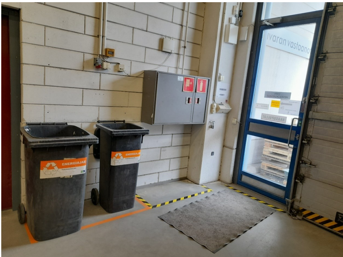
Kuva 10. Vastaanottoalueen alkusammutuslaitteiden alue 5S-menetelmän jälkeen
