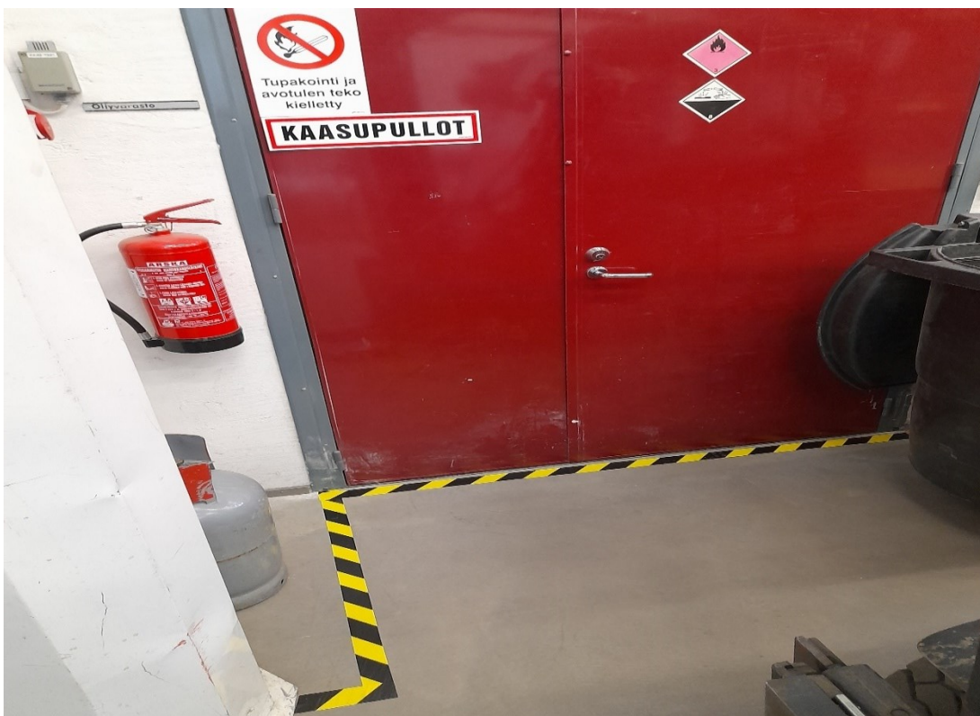
Kuva 12. Vastaanottoalueen toinen alkusammutuslaitteiden alue 5S-menetelmän jälkeen
