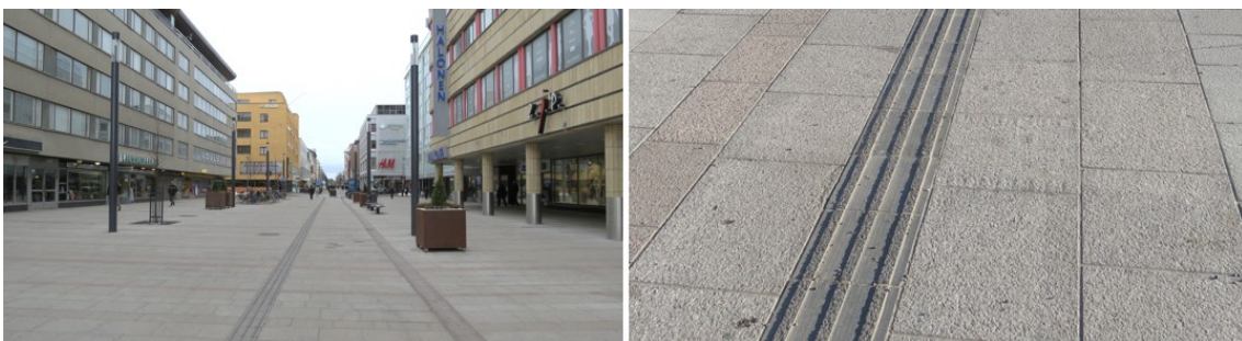
KUVA 16. Rotuaarin kävelykadun lämmitetty kiveysalue sekä näkövammaisia palvelevat taktiililaatat
