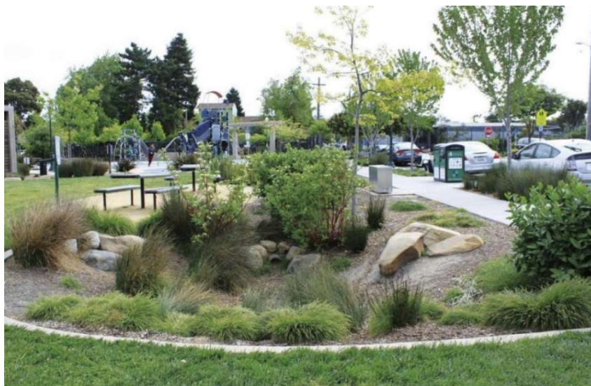
Kuva 12. Ote tieluiskan kuvakirjastosta: Esimerkkikuva sadepuutarhasta. (Tieluiska)
