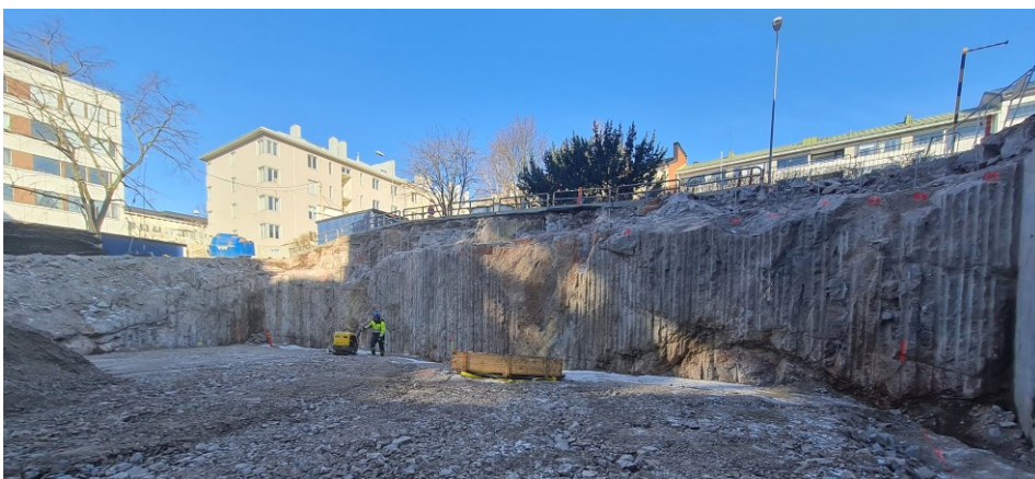
KUVA 10. Pohjatyöt loppusuoralla maaliskuun lopussa 2022 (Tölkö 2022)
