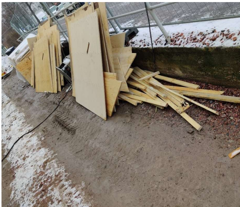
KUVA 5. Rakentamisessa syntyy paljon puujätettä mm: mittahukkana sekä esim muotteja tehdessä. Nämä voidaan mahdollisuuksien mukaan hyödyntää uudestaan. (Haring 2020)
