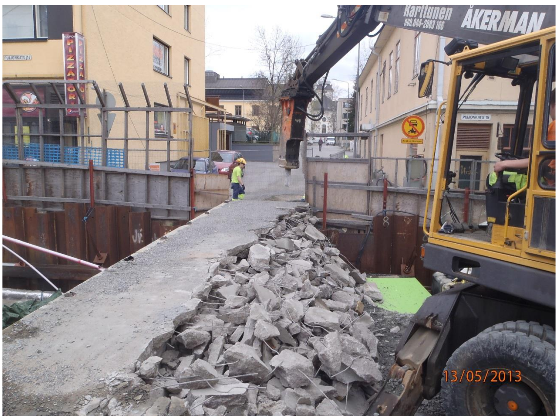
KUVA12. Lapinlinnankadun työnaikaisen ylikulkusillan purkutyö (Raatikainen 2013-05-13)
