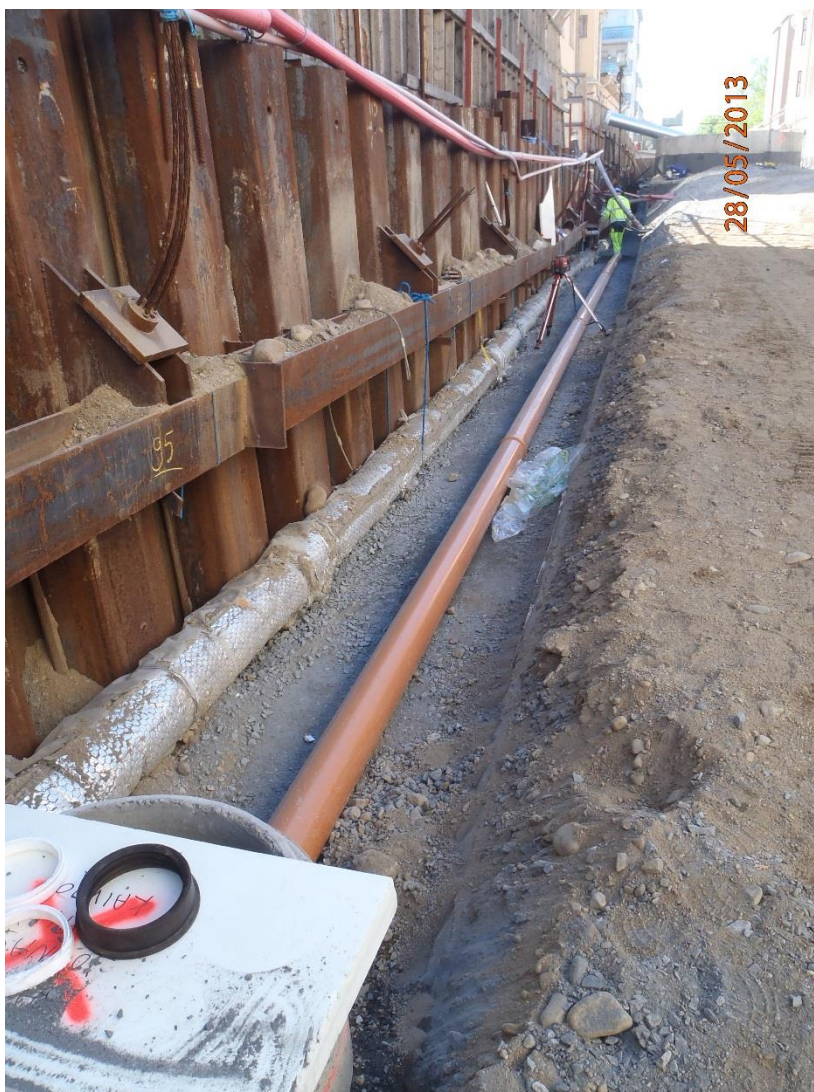
KUVA13. Jätevesirunkolinjan asennus. Runkolinjan vasemmalla puolella näkyy purettava työnaikainen runkolinja. (Raatikainen 2013-05-28.)
