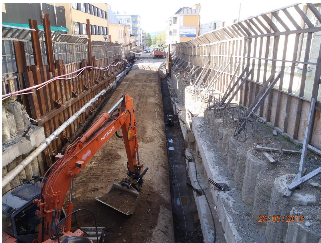
KUVA6. Puijonkadun täyttötöitä ajotunnelin vierustäyttövaiheessa (Raatikainen 2013-05-20)
