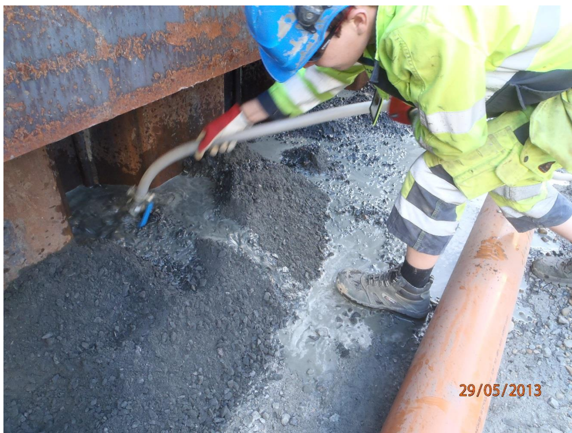
KUVA8. Ponttiseinän profiileihin jäävän täyttömaa-aineksen tiiviys varmistettiin runsaalla vedellä ja betonivibralla. (Raatikainen 2013-05-29)
