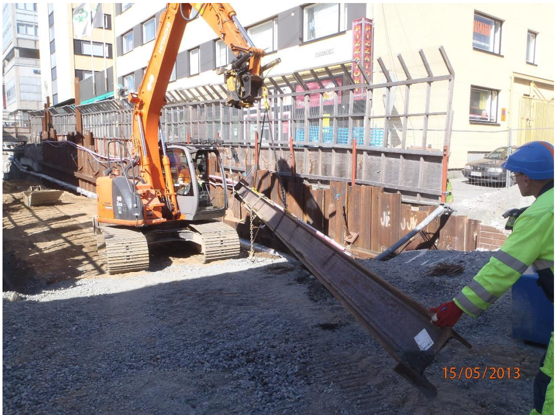
KUVA11. 12 metrisen ankkuripalkin nostaminen ajotunnelin ja ponttiseinän välisestä tilasta. (Raatikainen 2013-05-15)
