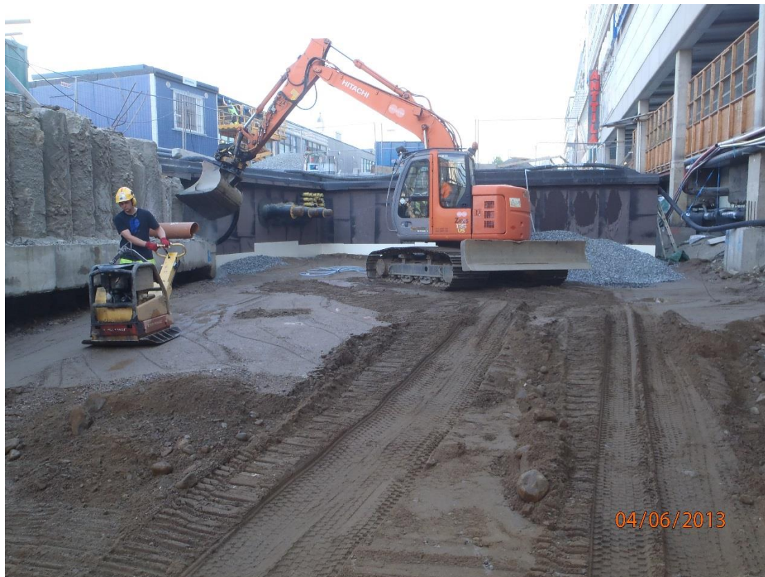
KUVA7. Täyttö- ja tiivistystyötä Anttilan kiinteistön edustalla (Raatikainen 2013-06-04)
