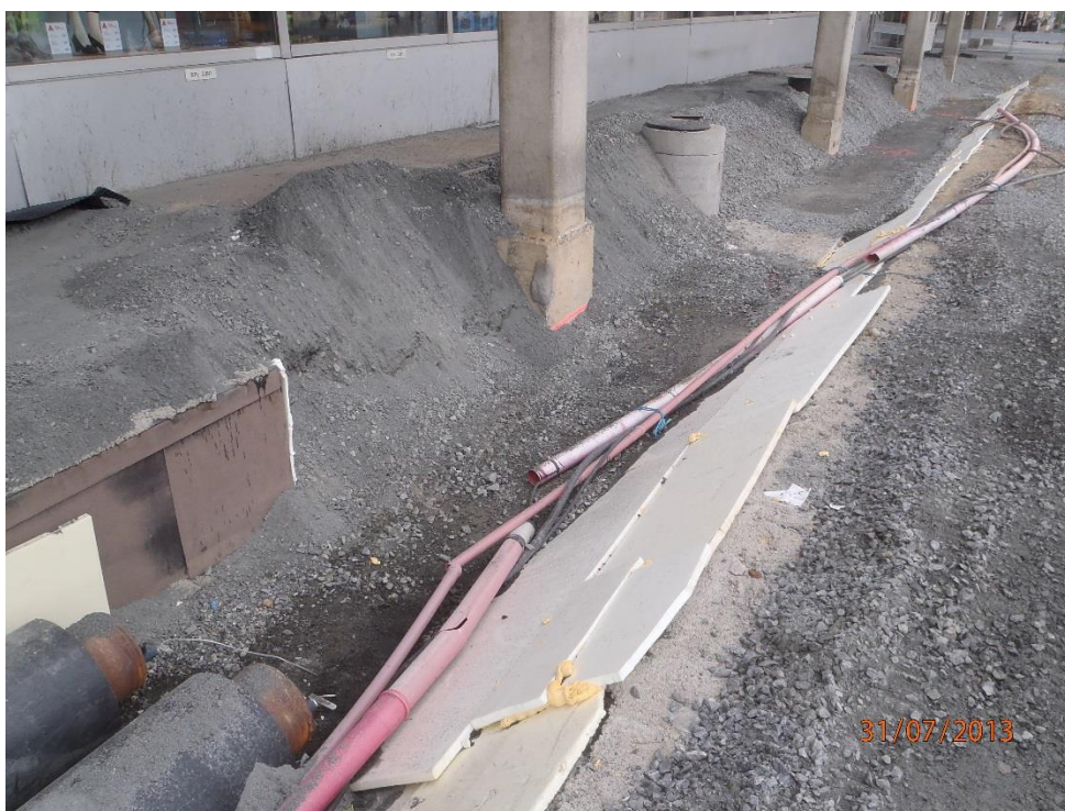
KUVA14. Kaukolämmön runkolinja sekä maakaapeleita rakennusvaiheessa Anttilan edustalla. (Raatikainen 2013-07-31.)
