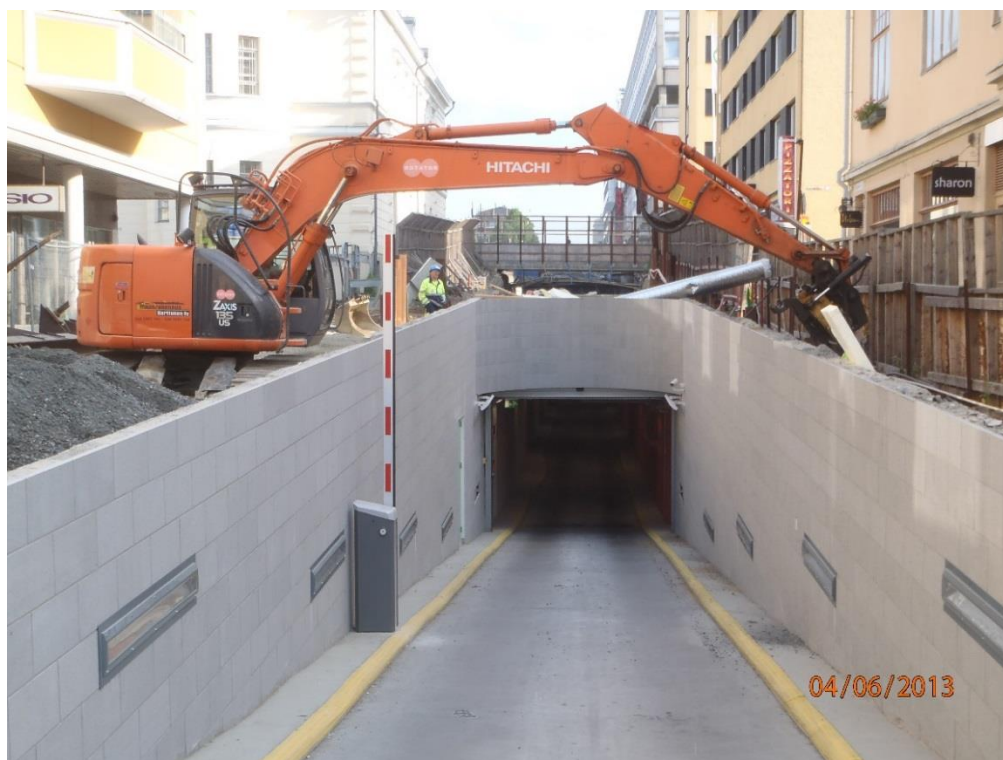
KUVA4. Osa ankkuripalkeista jouduttiin poistamaan sisäänajotunnelin ylitse. (Raatikainen 2013-06-04)
