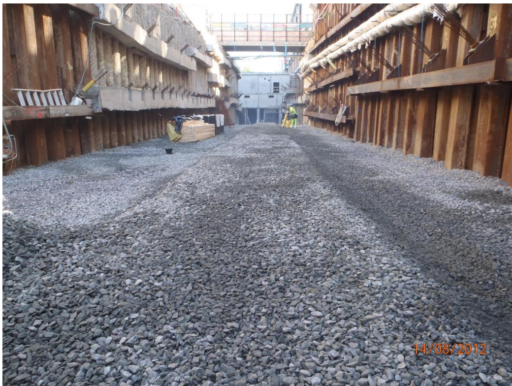
KUVA1. Puijonkadun maaleikkaus ajotunnelin pohjatyövaiheessa kesällä 2012 (Raatikainen 2012-08-14)
