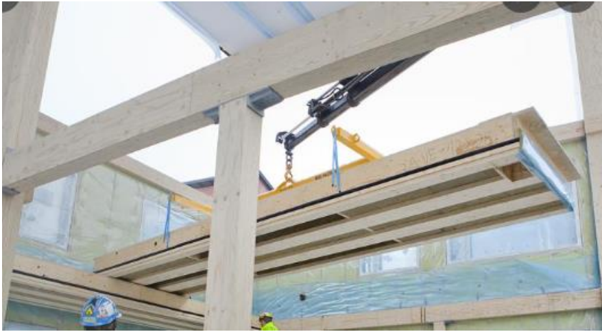
KUVA 7. Kertopuu runkoinen välipohja elementti asennettavana (9)
