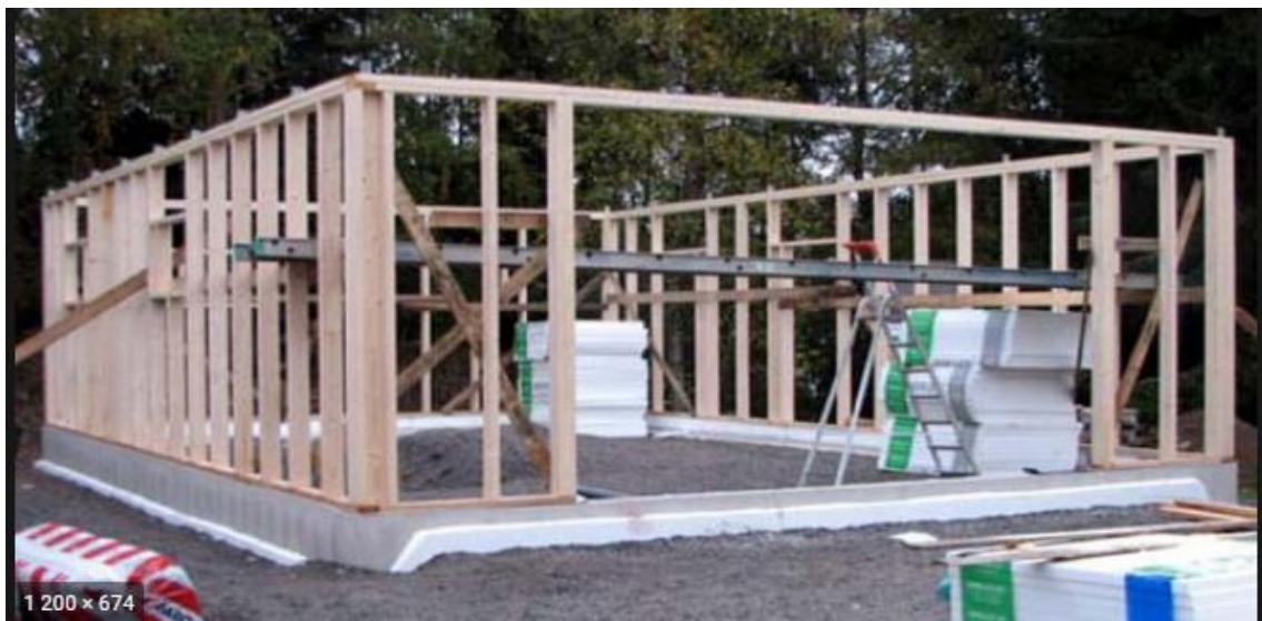
KUVA 1. Rakennuksen runko paikalla rakennettuna (2)
