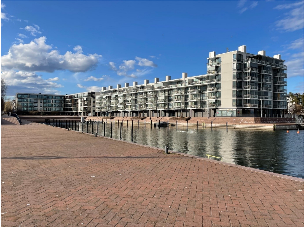
Kuva 4. Venesatama-altaan itäpuolella sijaitsee Gullichsen – Vormala -arkkitehtitoimiston vuonna 2000 suunnittelema asuin kerrostalo Pursilahdenranta 1–2. 10
