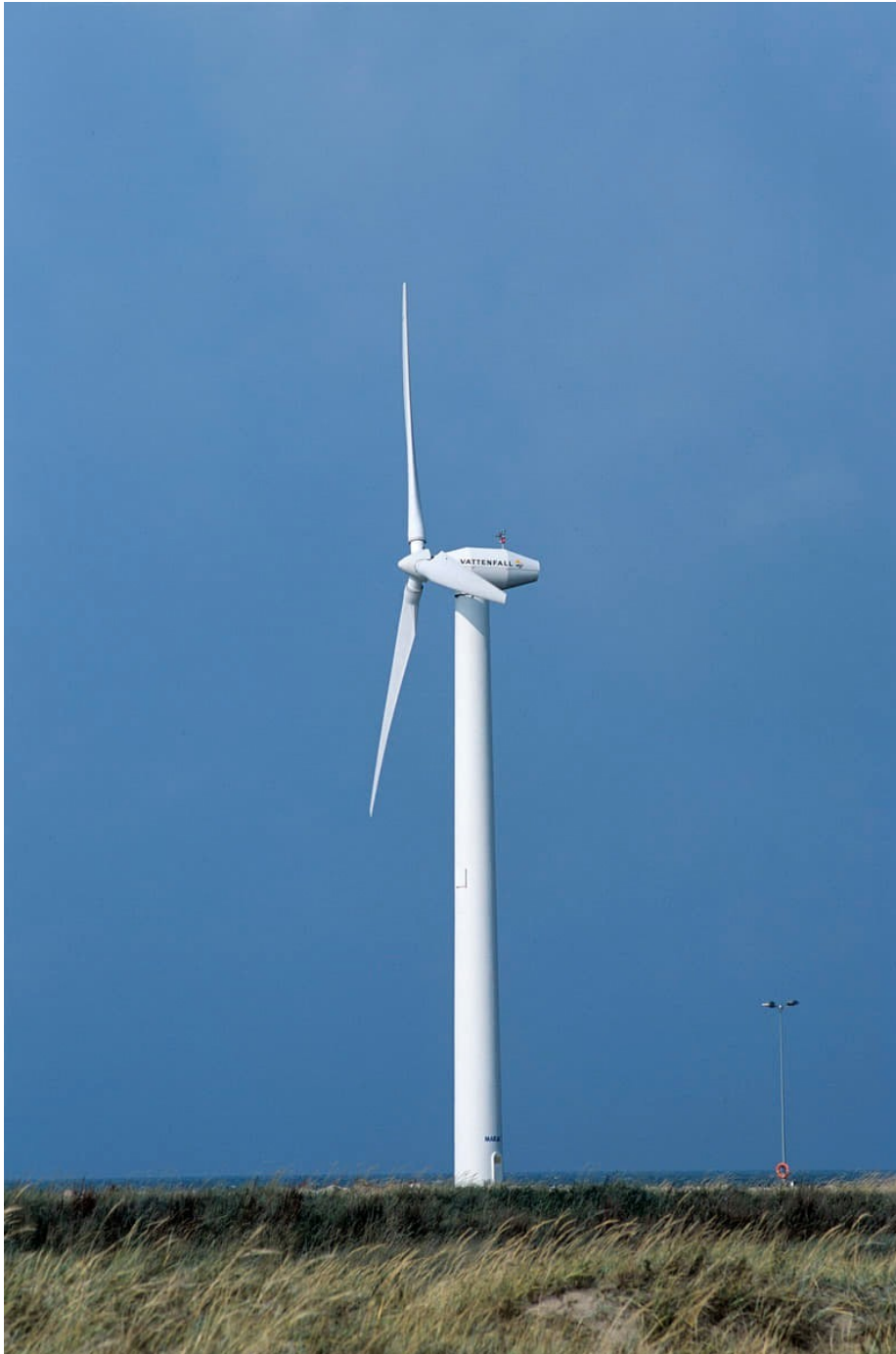
Kuva 5. Vaaka-akselinen voimala (Peltonen 2002).
