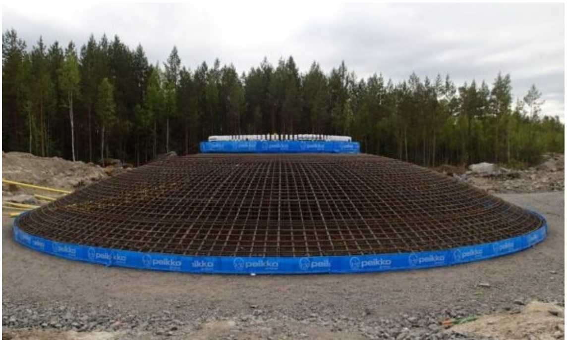
Kuva 4. Tuulivoimalan perustus (EPV tuulivoima 2021).
