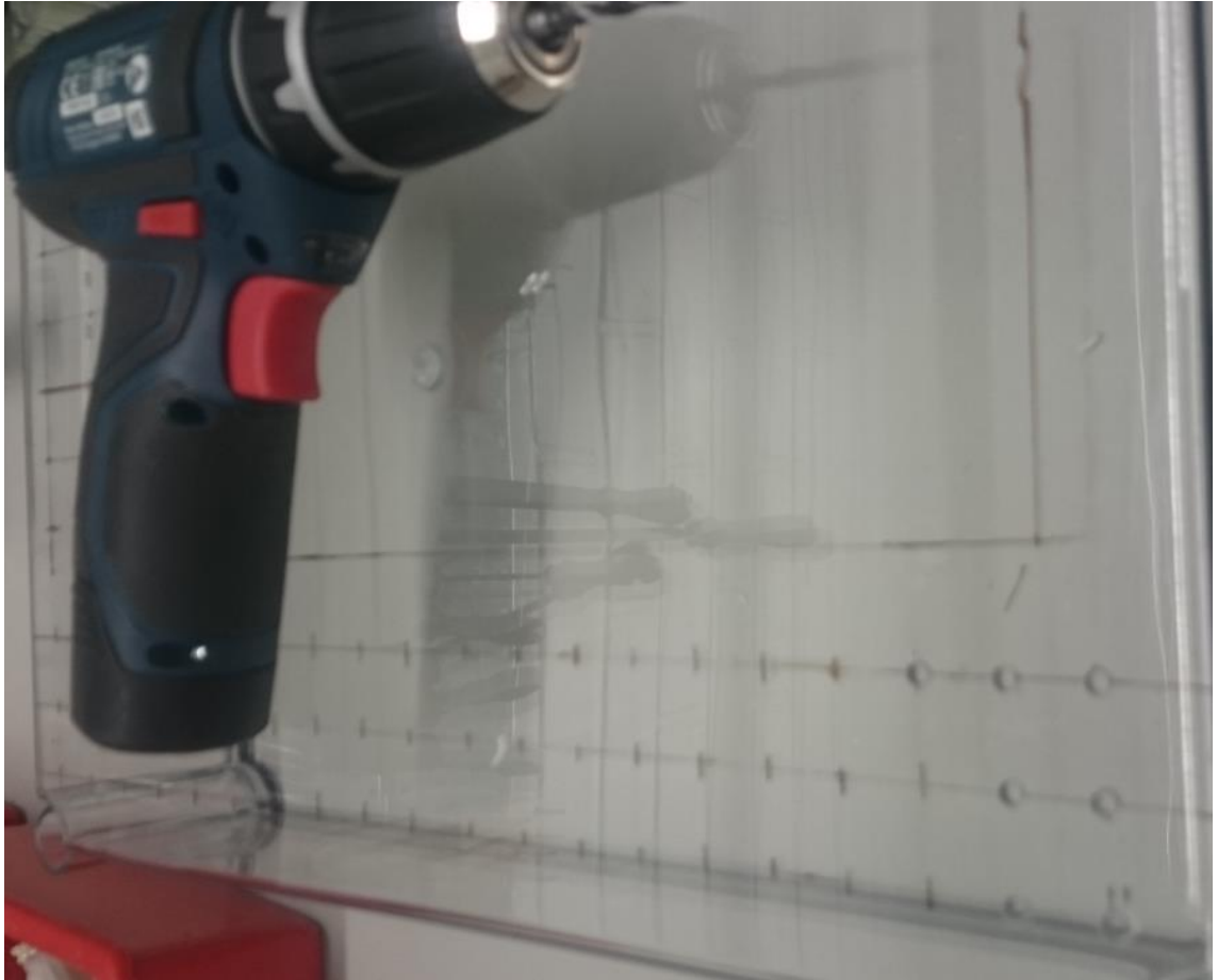
Kuva 7. Releketelon läpivientien teko.
