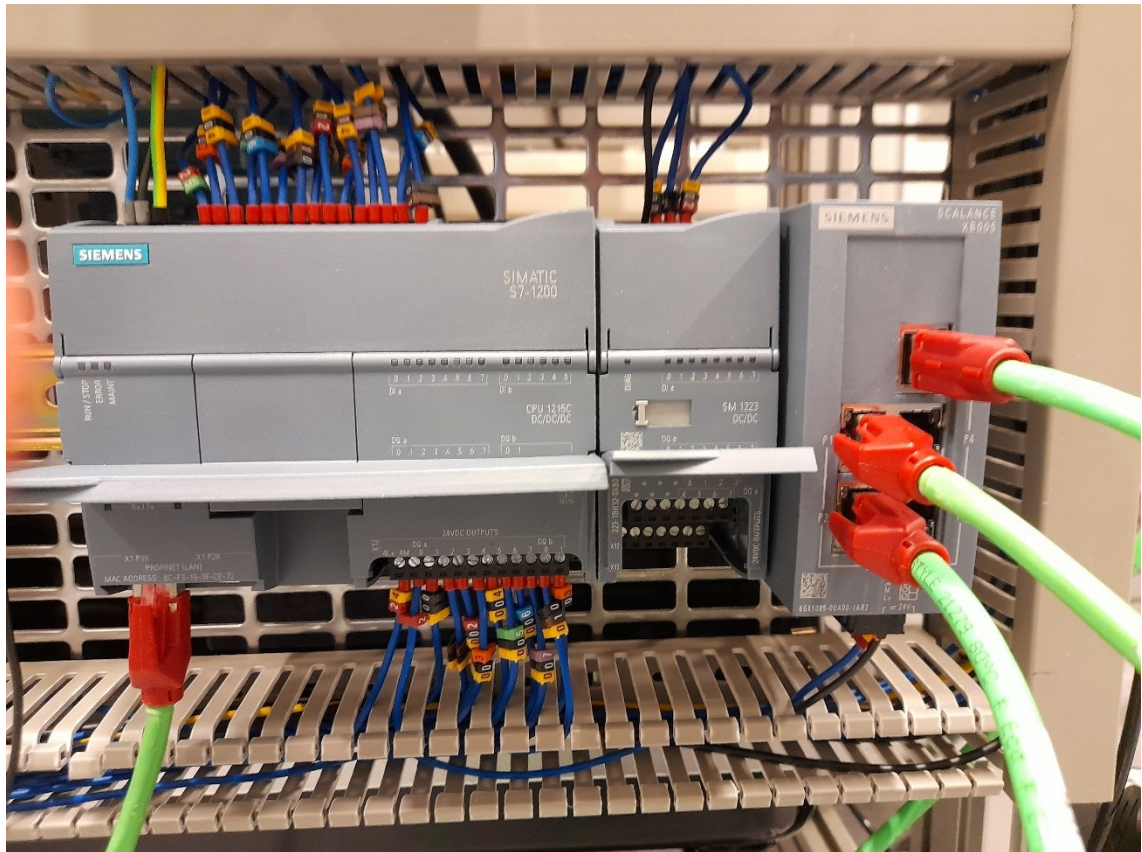
Kuva 5. S7-1200 ohjelmoitava logiikkaohjain ja lisärelemoduuli
