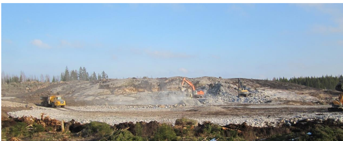
Kuva 1. Loviisan työmaan yleiskuva.
