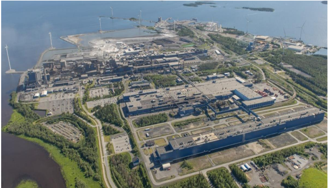
Kuva 1. Tornion tehdasalue (Outokumpu 2021c)
