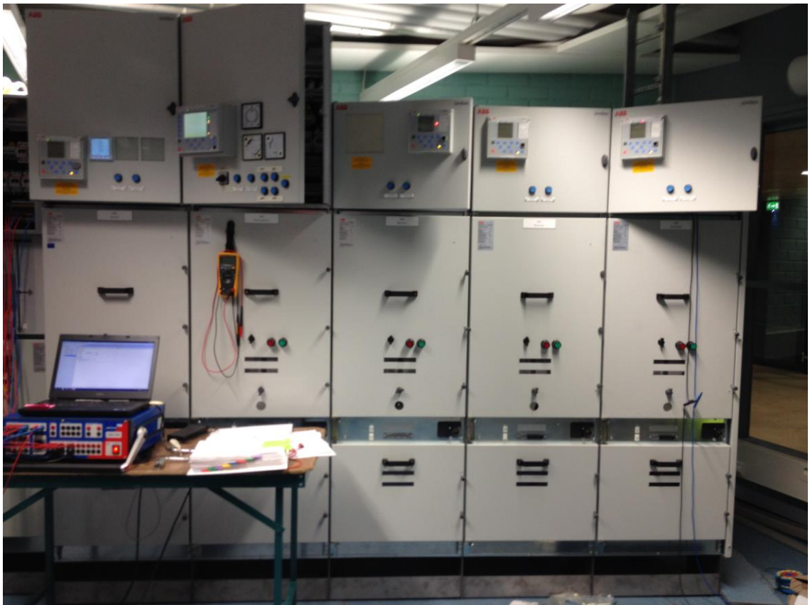
Kuva 5. 10 kV kojeisto.
