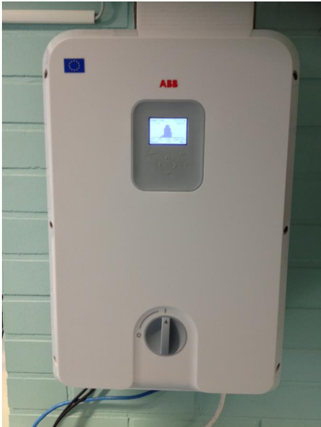
Kuva 11. Aurinkopaneelien ohjauskeskus.
