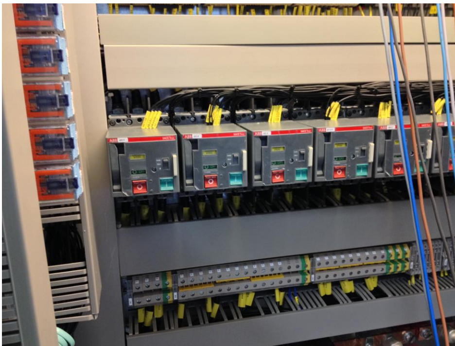
Kuva 4. 110 kV kojeiston toimintaa simuloivia SACE Tmax-minikatkaisijoita.
