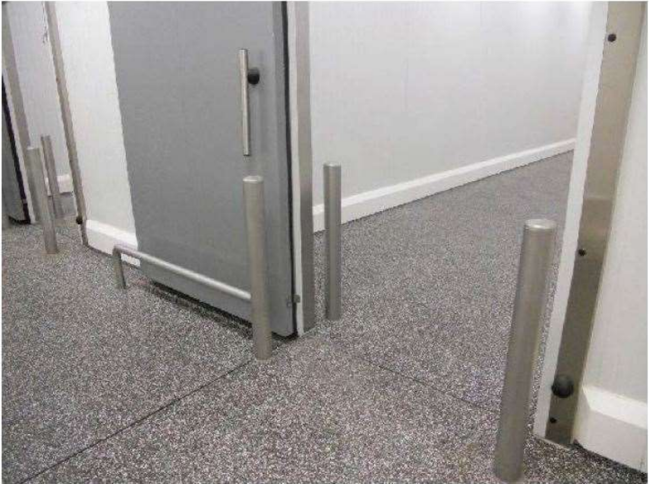
Kuva 7. Esimerkkejä seinän ja oven rakenteiden suojelemiseksi käytettävistä tulpista ja törmäyssuojista (EHEDG 2014b, 91).
