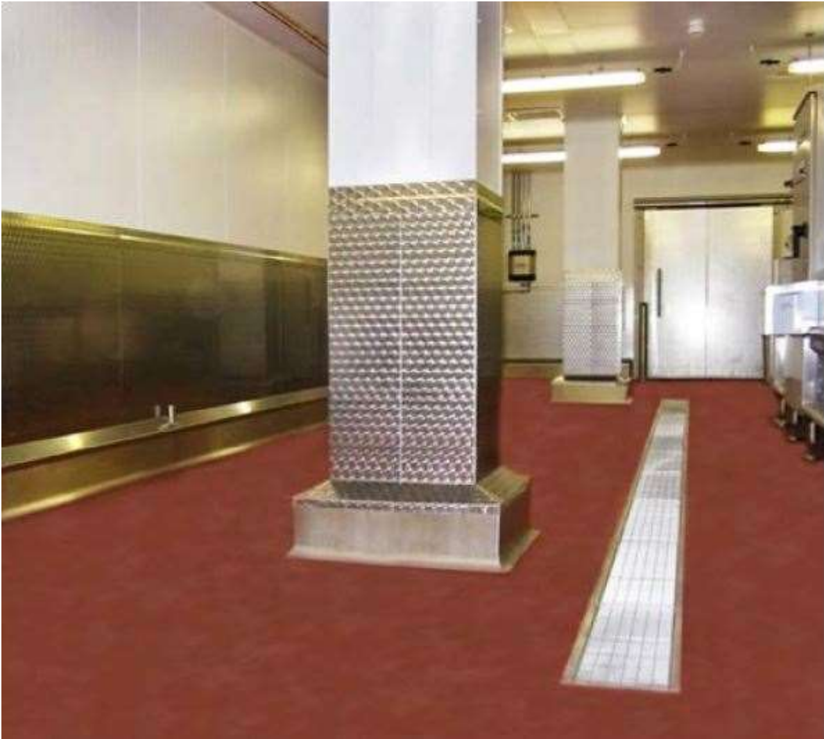
Kuva 6. Sokkelin teräspinta nostettu seinälle (EHEDG 2014b, 90).
