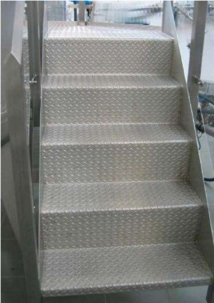
Kuva 9. Portaikon yhtenäiset askelmat (EHEDG 2014b, 111).
