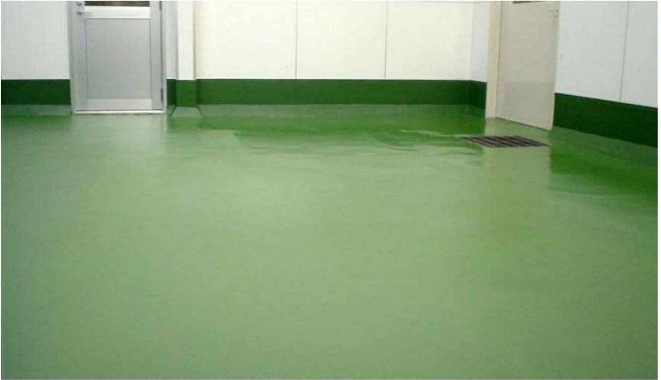
Kuva 1. Lattia kallistuu lattiakaivoa kohti (EHEDG 2014b, 53).
