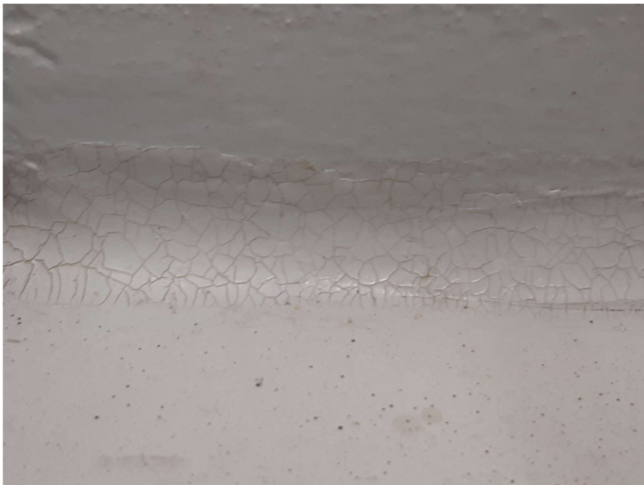
Kuva 15. Seinän ja lattian välinen silikonisauma
