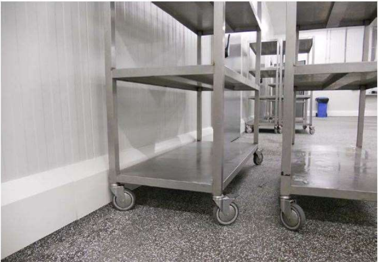
Kuva 5. Esivalmisteinen polymeerikomposiittisokkeli sileällä geelipäällysteisellä viimeistelyllä (EHEDG 2014b, 88).
