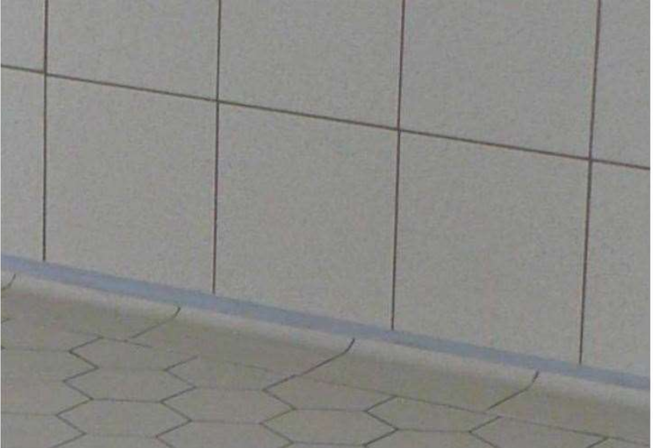
Kuva 4. Laattaseinän ja lattian välinen sauma (EHEDG 2014b, 85).
