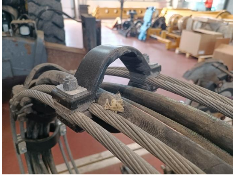
Kuva 26. Valettu varaosa asennettuna käyttökohteeseen
