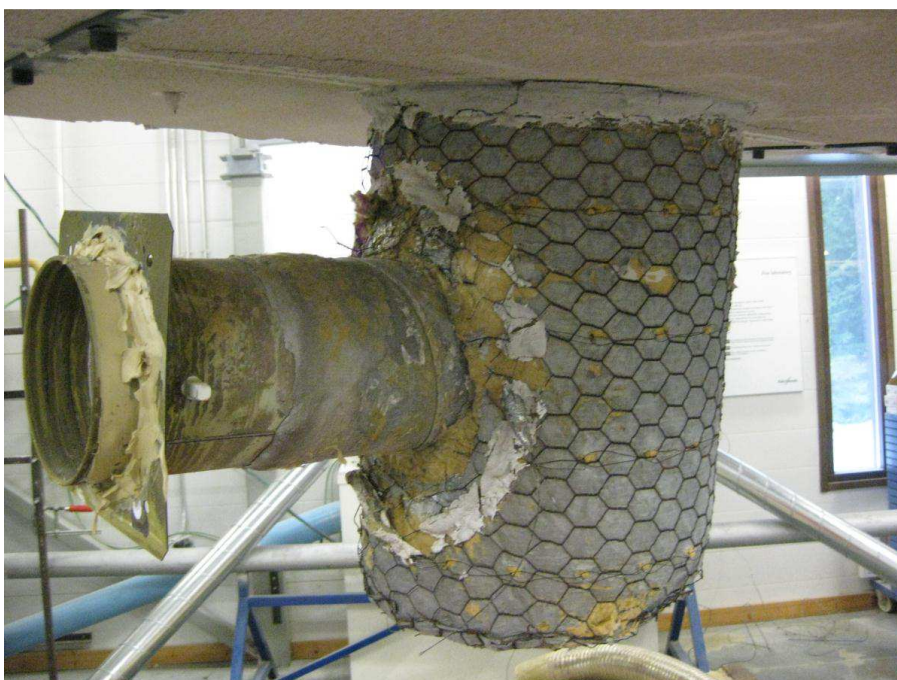
Kuva 13. Applikaatiosta on poistettu osa eristeitä
