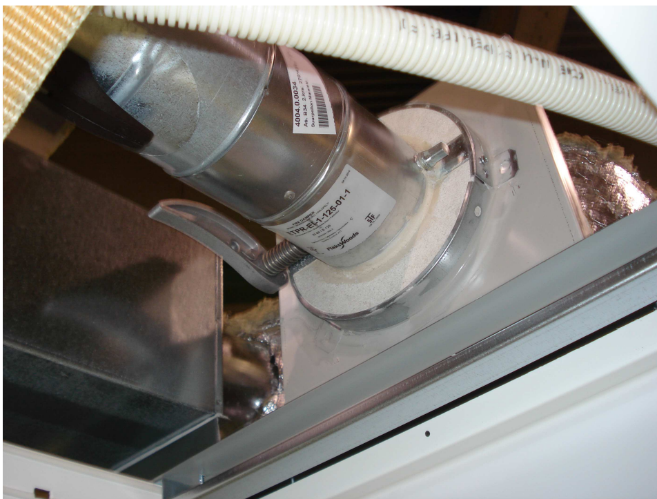
Kuva 17. Palopelti elementin huoltoluukusta tarkasteltuna
