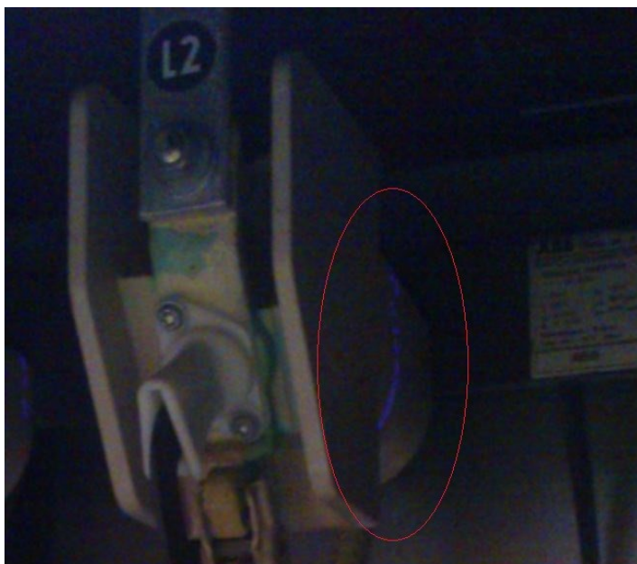
Kuva 8. Näkyvä hohtopurkaus 20 kV kuormaerottimen tukieristimen ympärillä (Paikallis-Sähkö Oy)
