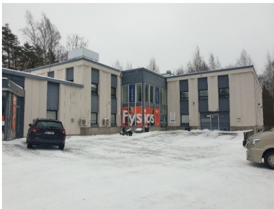
Kuva 2. Kouvolan Fysios Aktiivin julkisivu (Kallela 2022)
