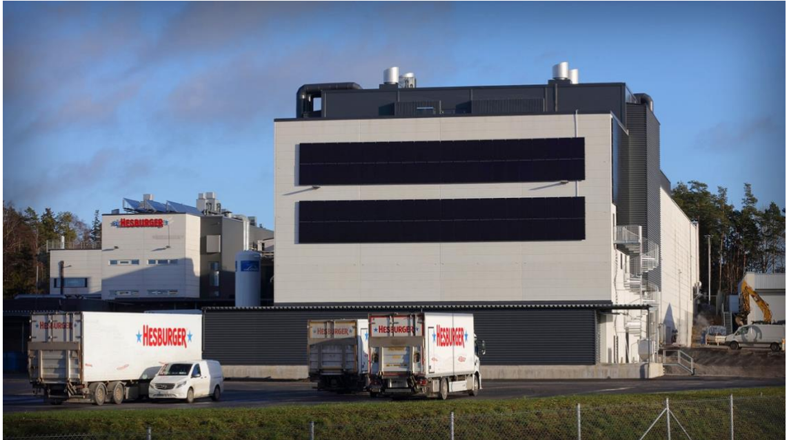
Kuva 1. Hes-Pro:n tuotantolaitos ja keskusvarasto (Ilmatuote n.d.)
