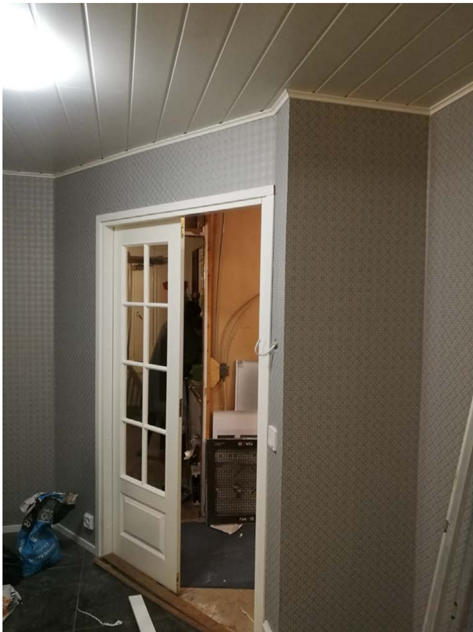
Kuva 7. Ovenpielessä ohjaus lattialämmitykselle ja valaistukselle
