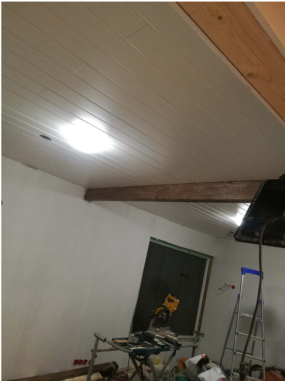
Kuva 5. Huoneen oma valaistus korvaa työmaavalaistuksen
