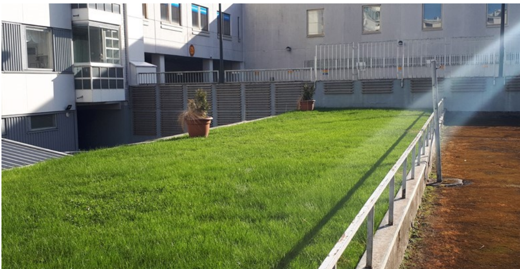
Kuva 6. Heinäviherkatto autohallin kansirakenteen päällä.
