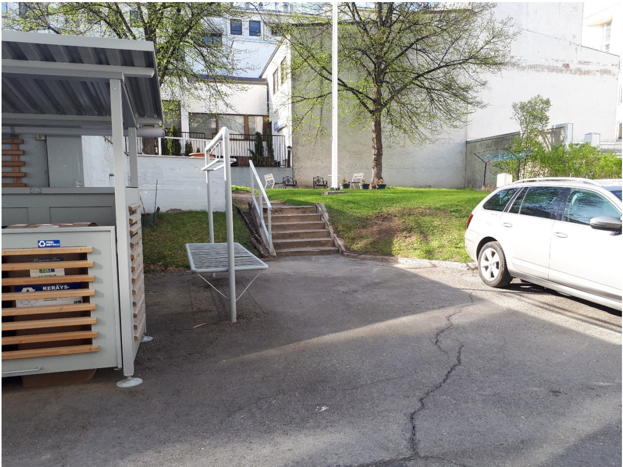
Kuva 10. Portaat johtavat huoltopihalta oleskelupihalle.
