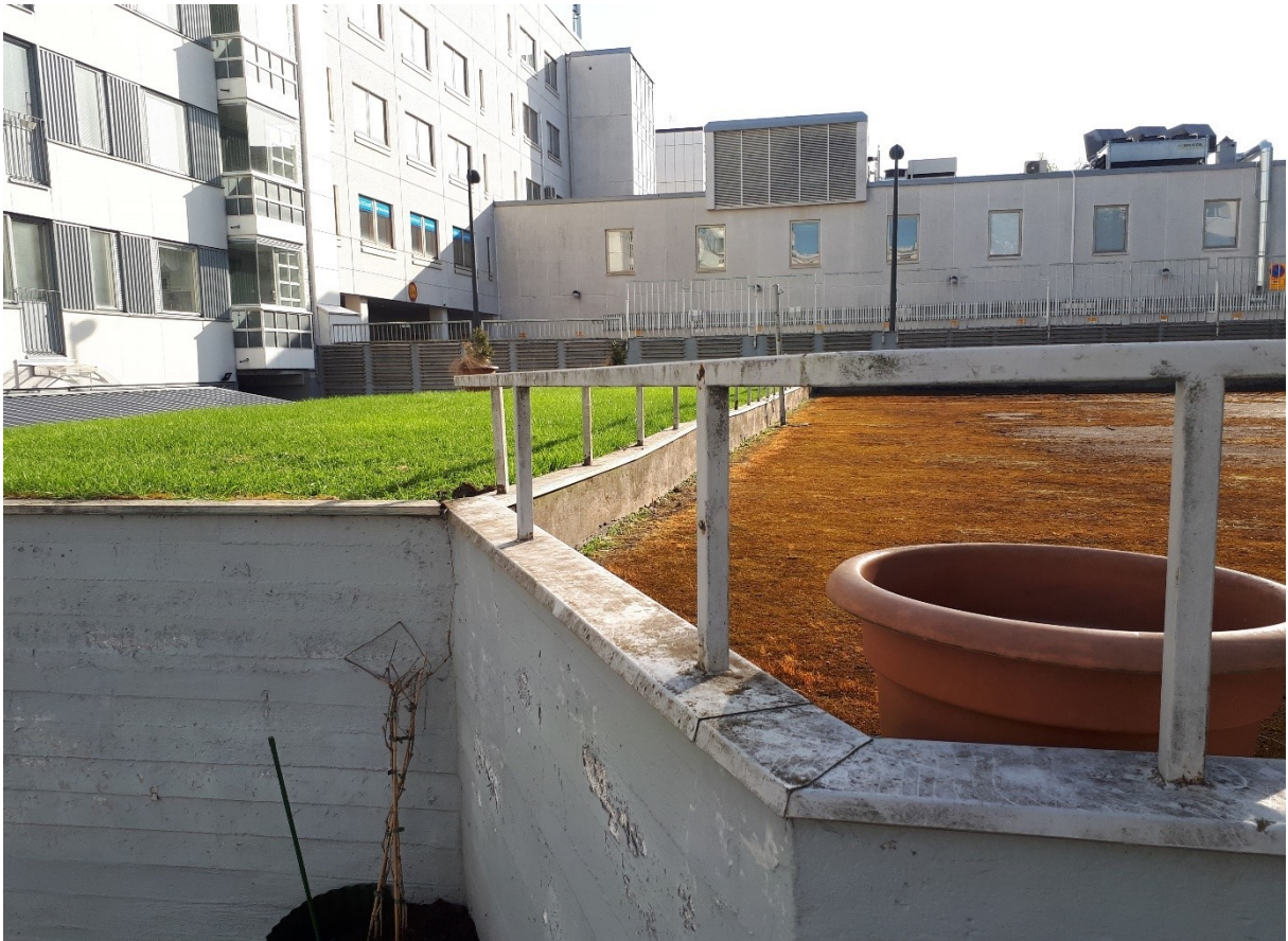
Kuva 11. Autohallin päällä on heinäviherkatto.
