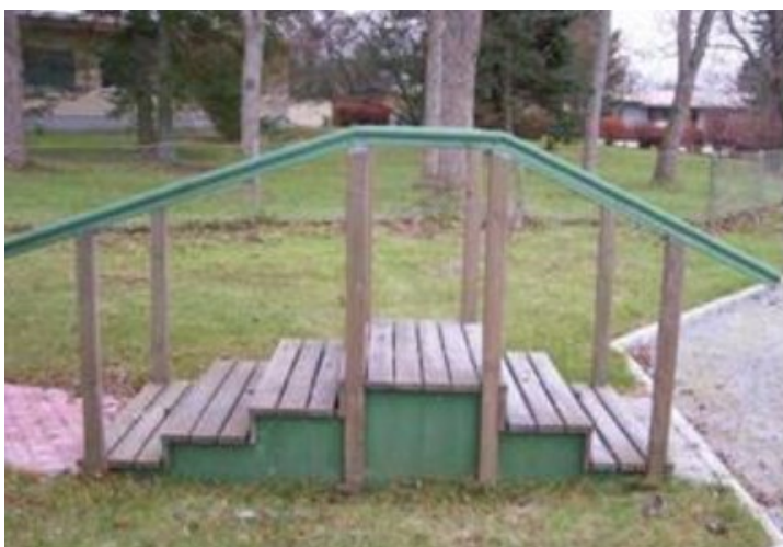
Kuva 9. Porrassilta Paltanpuiston palvelukeskuksen pihalla. (Malin)
