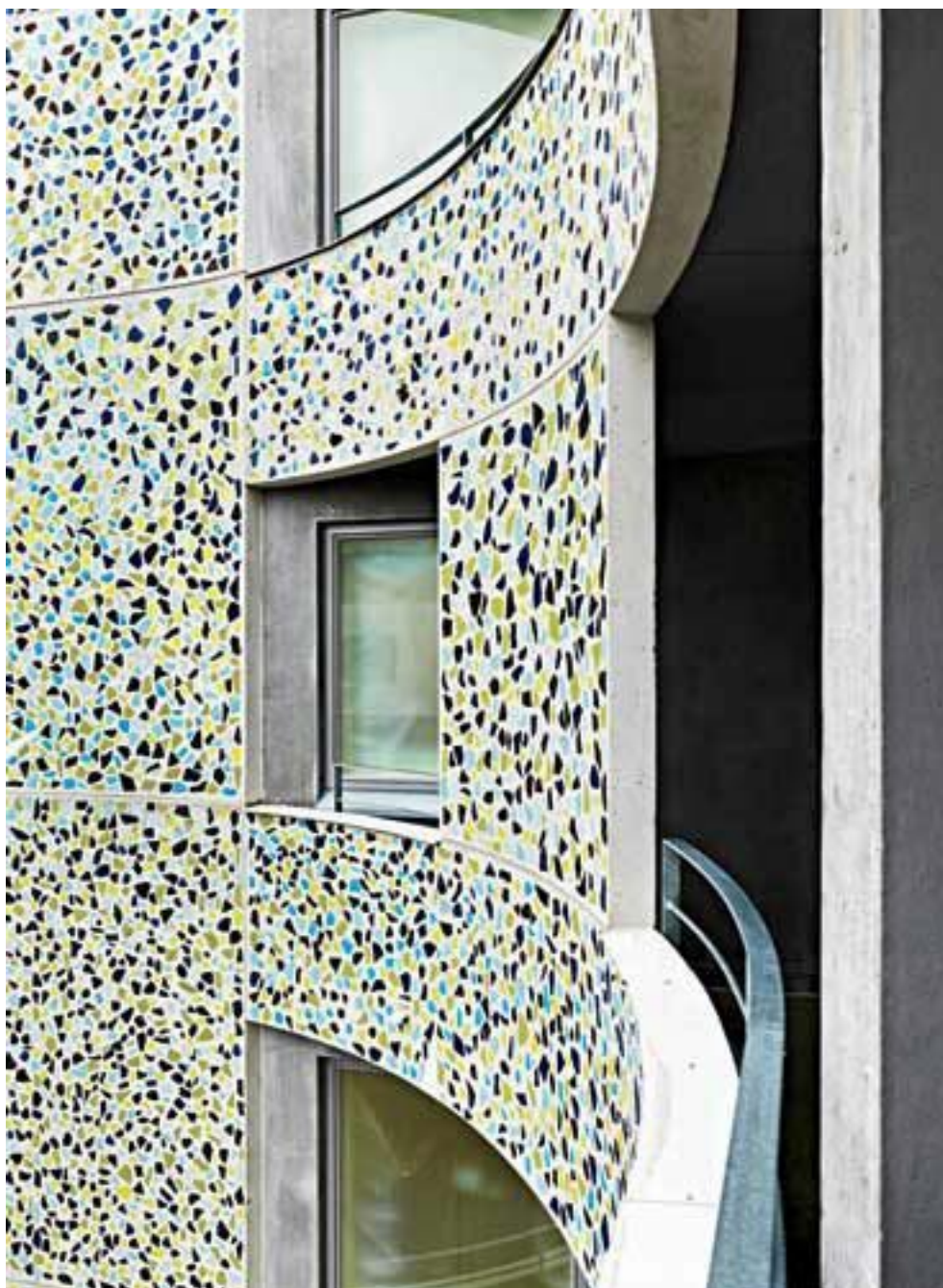
Kuva 37 Asunto Oy Helsingin Flooranaukio. Arkkitehtitoimisto Heikkinen-Komonen. Sisäpihan julkisivussa vaaleata betonia värittää keramiikka.
