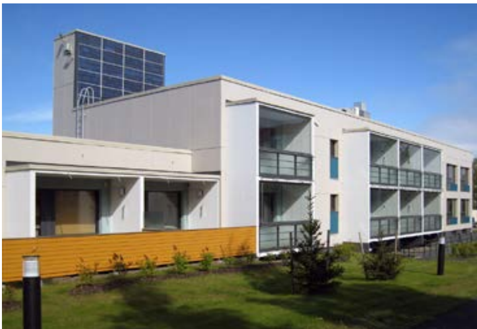
Kuva 51 Kerrostalo-kohte madalluksen ja peruskorjauksen jälkeen.
