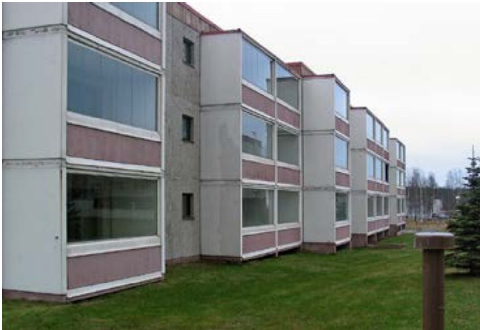
Kuva 50 Kummatin Ratsukadun kolmi-kerroksinen asuin-kerrostalo ennen madallusta ja peruskorjausta.
