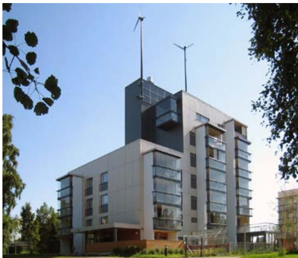
Kuva 49 Ratsukatu 7 asuinkerrostalo madalluksen ja peruskorjauksen jälkeen.
