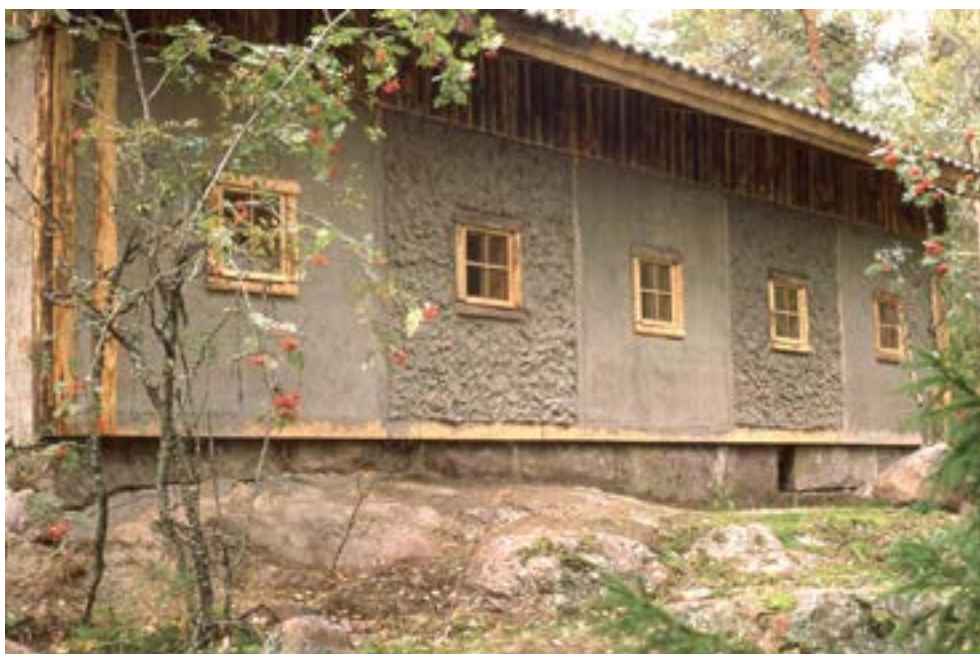
Kuva 21 Sauna rakennettiin juhlatalon jälkeen. Kuva 22 Savirappaus on kestänyt hyvin säiden rasitusta. Kuva 23 Ulkoseinään kokeiltiin erilaisia savirappauksia. Kuvat: Teuvo Ranki
