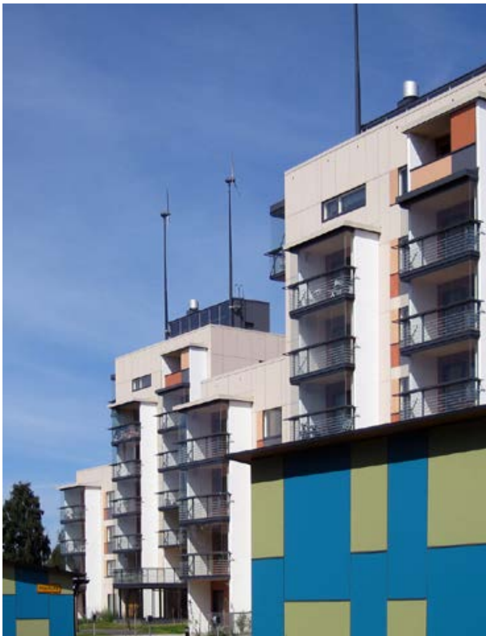
Kuva 52 Kummatin asuinkerrostalo- kohde madalluksen ja peruskorjauksen jälkeen.
