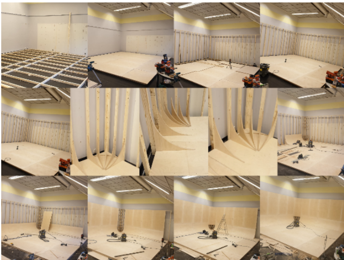
Kuva 8. Cycloraman rungon rakennusvaiheet.
