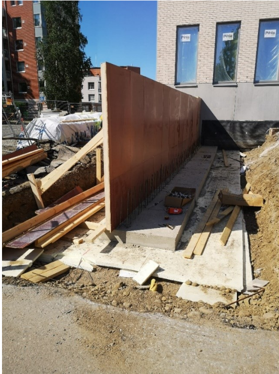
Kuva 10. Tukimuuriseinämuotti raudoittamista ja tuplaamista vaille valmis (Jesse Laukkanen).
