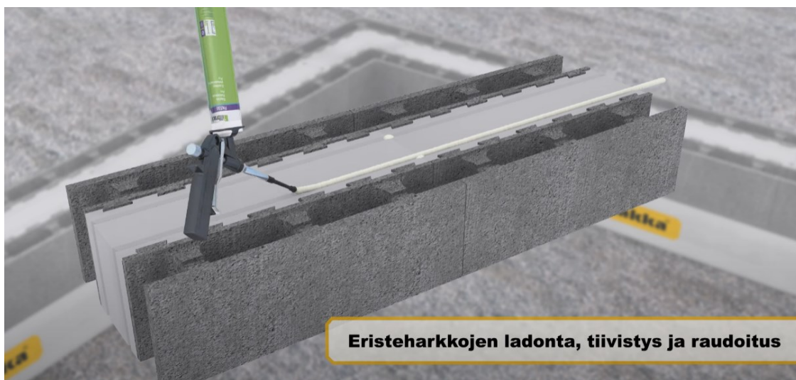
Kuva 3. Eristeessä olevat urat helpottavat vaahdon levittämistä (Lakka – Lakka konserni 2016).
