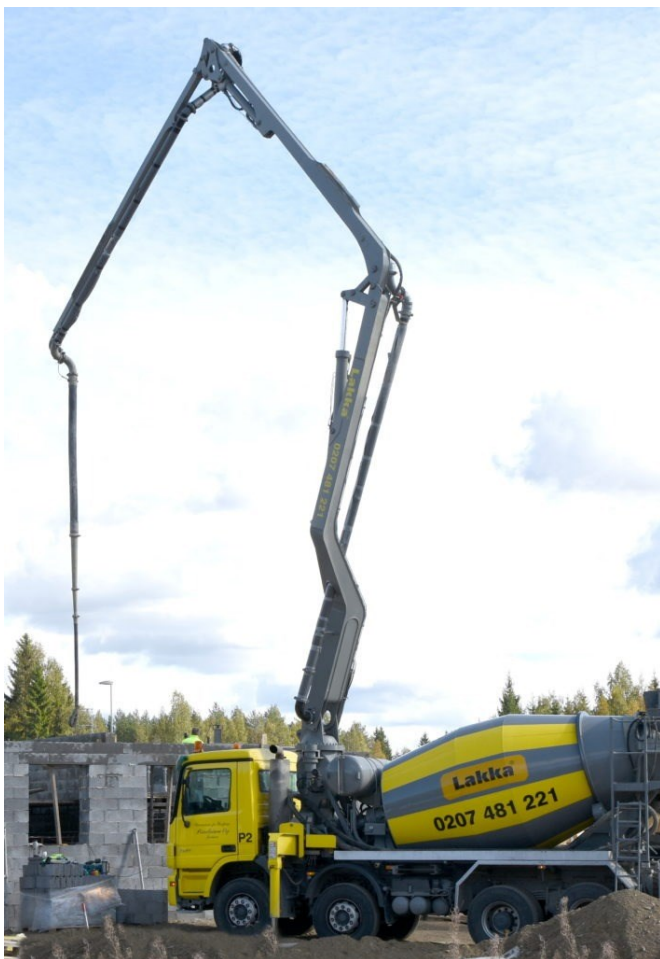
Kuva 8. Betoninkuljetusauto varustettuna omalla pumpulla (Lakan Betoni -konserni 2022).
