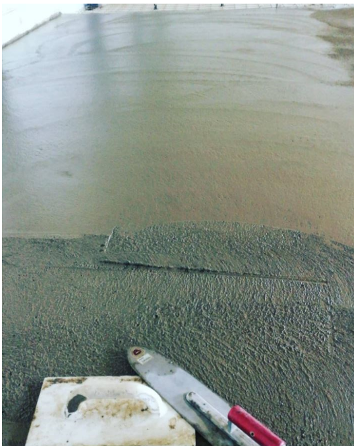
Kuva 6. Lattiabetonin työstettävyyteen vaikuttaa betonin notkeus ja käytettävän kiviaineksen raekoko (Jesse Laukkanen).
