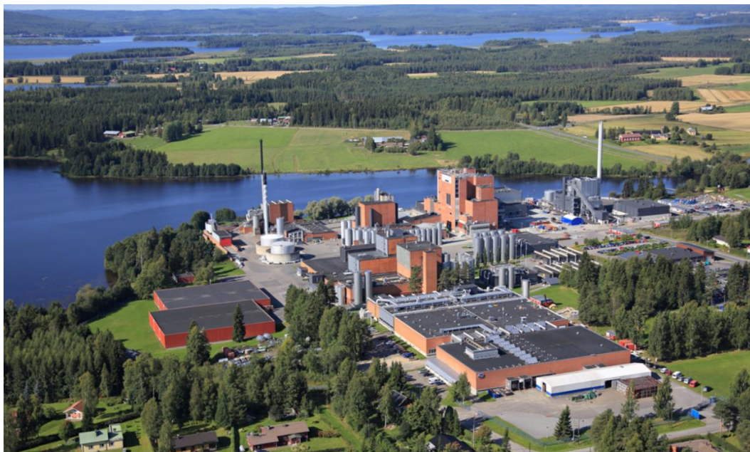
KUVA 1. Lapinlahden tehdas onkiveden rannalla. (Rekrytointi.com julkaisuaika tuntematon)
