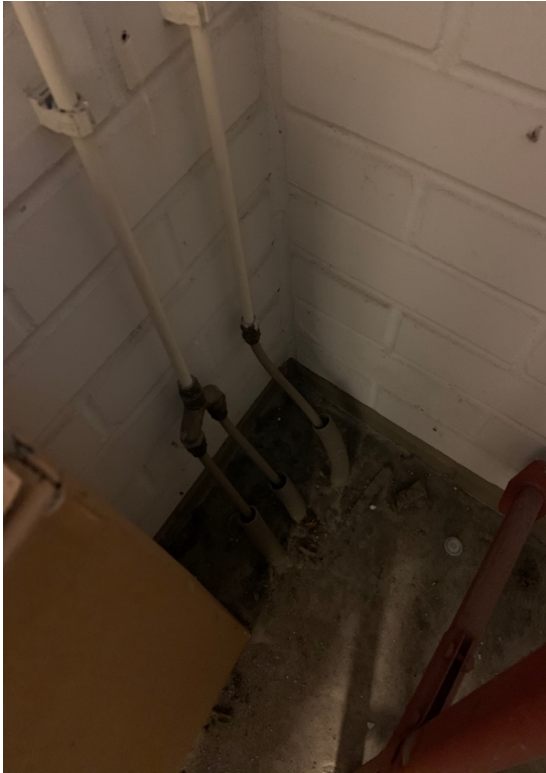
Kuva 12. Inva WC:n vesijohdot upotettu lattiaan.
