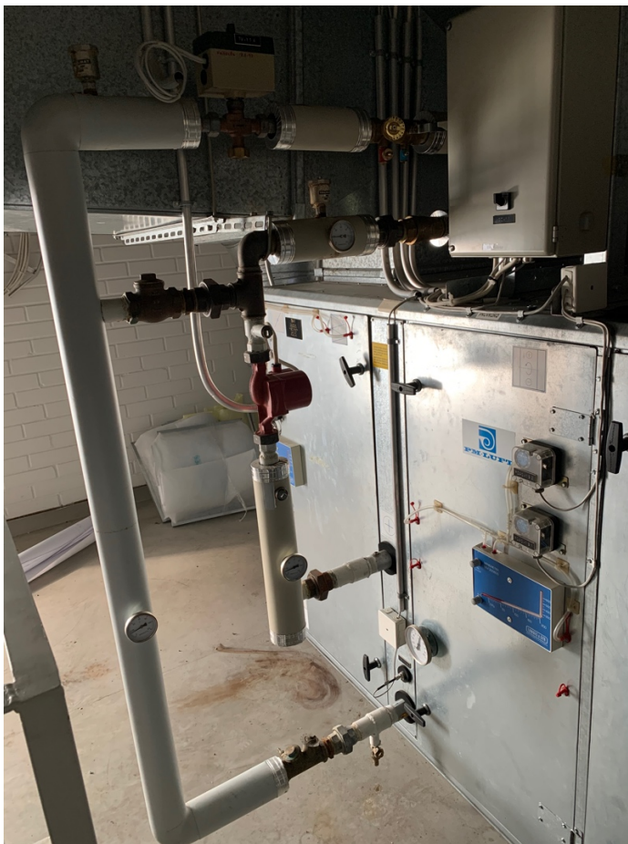
Kuva 4. Ilmanvaihtoverkoston lämmitysputket.
