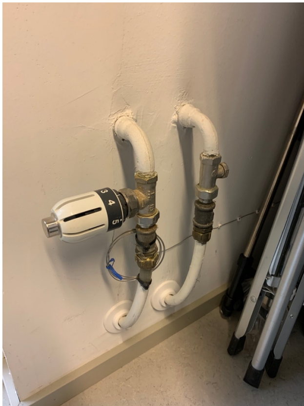
Kuva 3. Lattialämmityksen säätö.
