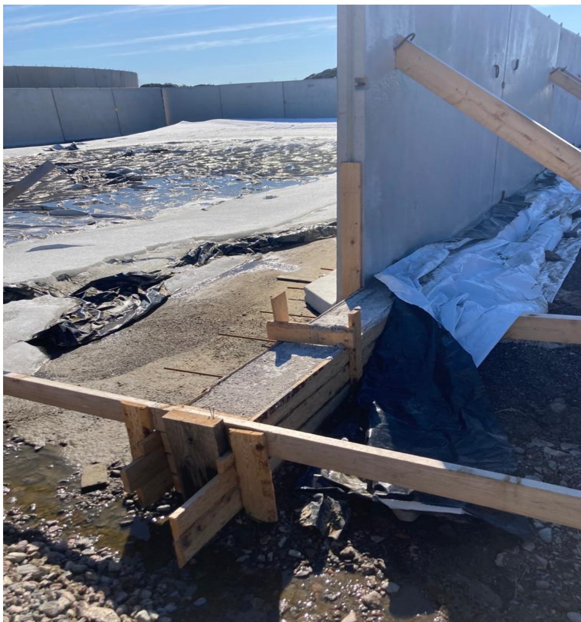
KUVA 7. Valettu taka-antura ja sen muotti
