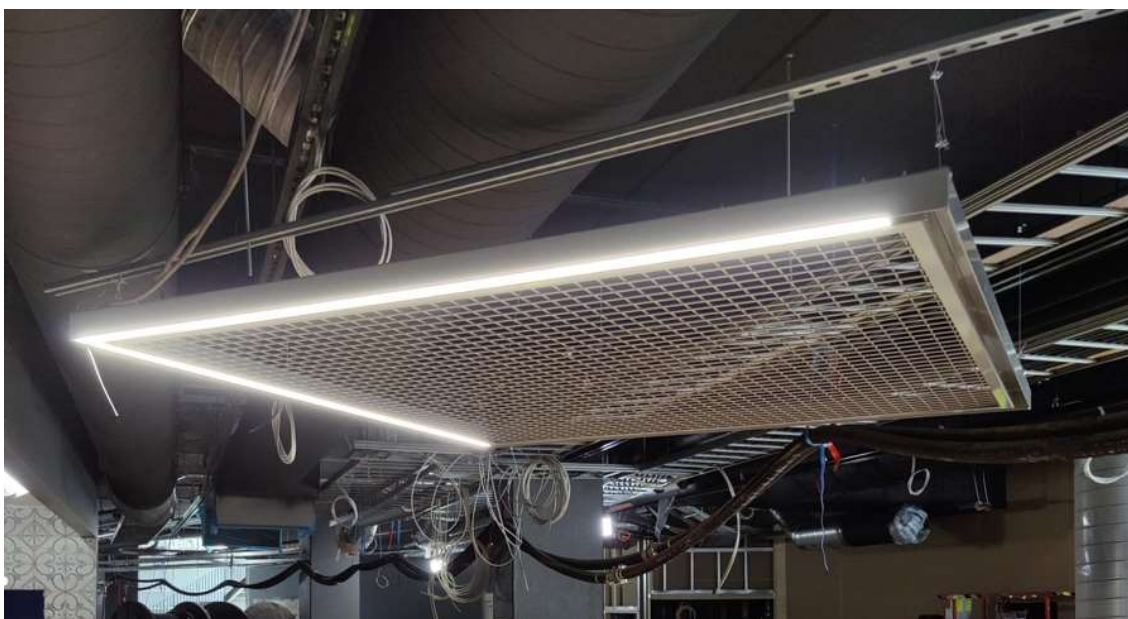
KUVA 3. Valokuva asennetusta mallilautasta (Kaivola, SRV Oy)
