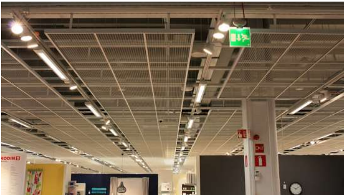
KUVA 1. Metalliverkkokatto (Merituuli, Inlook Group Oy 2017)
