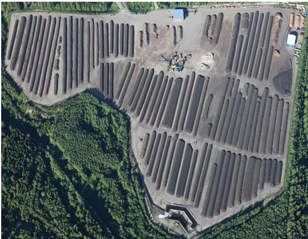
Kuva 2. Ilmakuva Metsäpirtin kompostointikentästä [5.].
