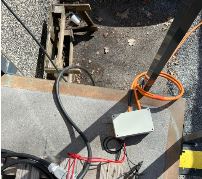
KUVA 16. Kytkentärsia, joka liitetään HESS-järjestelmän ES-suuntaajaan.
