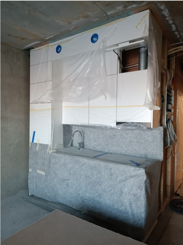
Kuva 7. Työmaalla tehty Tekniikkastudion suojaus.
