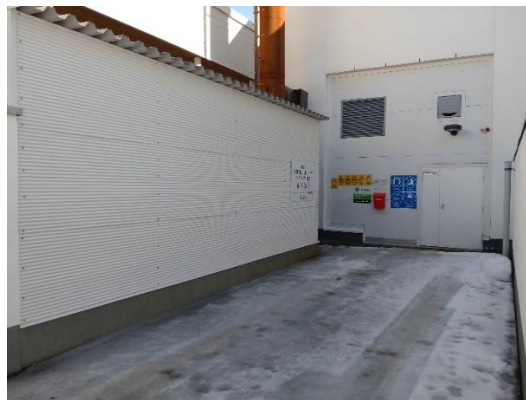
Kuvio 19. Uimahallin lämpökeskuksen sisäänkäynti ja öljyn purkupaikka
