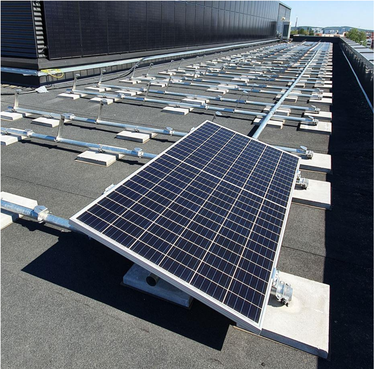
Kuvio 8. Aurinkopaneeli asennus bitumikatolle lisäpainoilla
