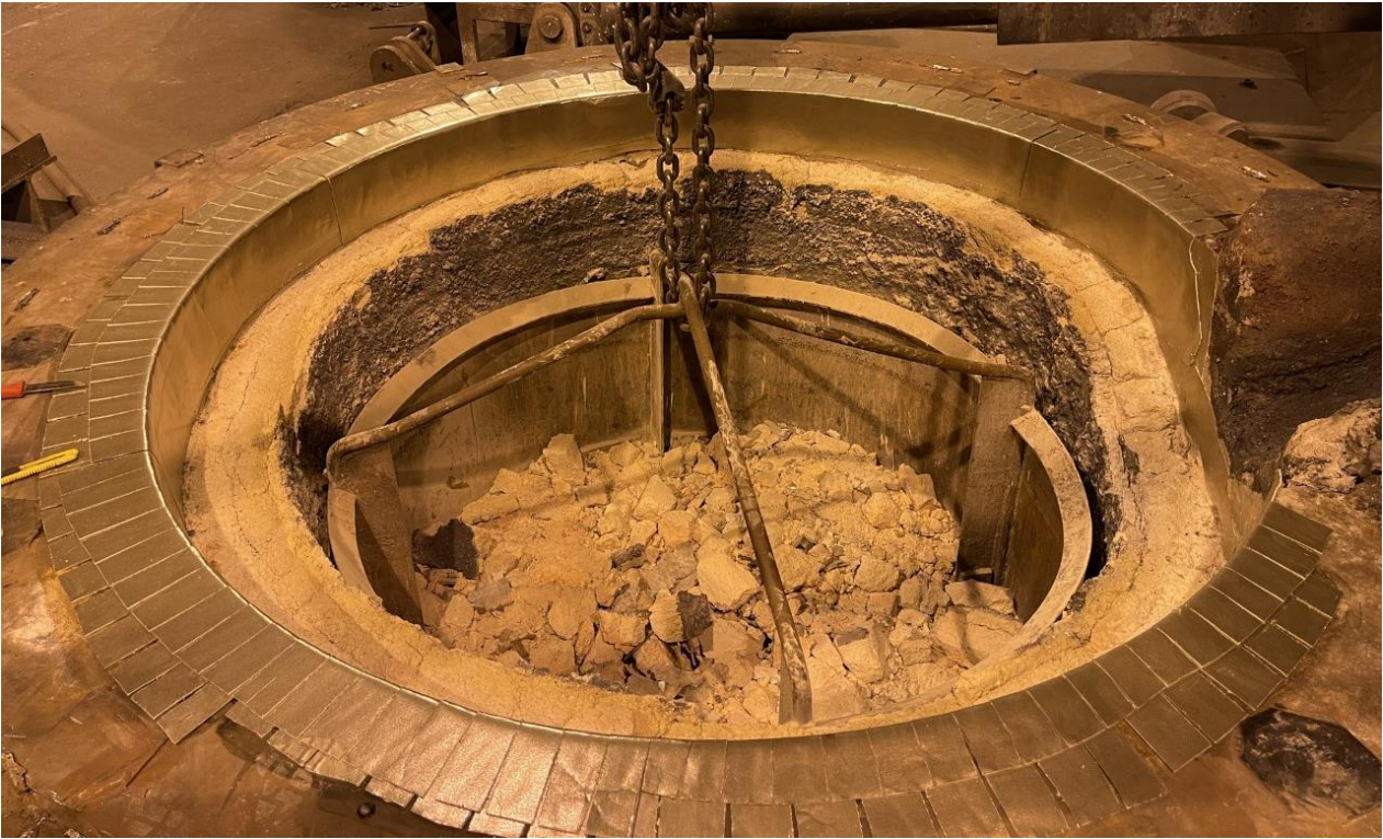
Kuvio 20. Vuorauksen yläosa purettuna ja mikaniitti levyt asennettuna
