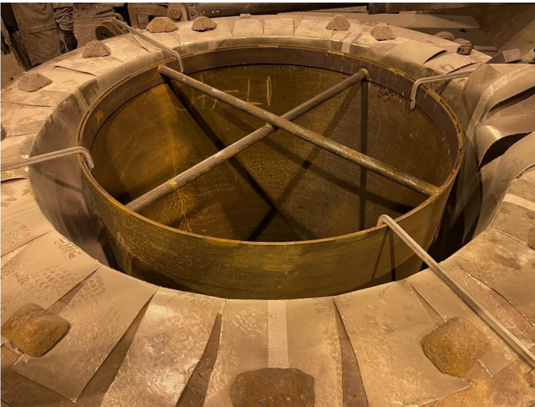
Kuvio 15. Vuoraussabloona asennettuna ja keskitettynä uuniin.
