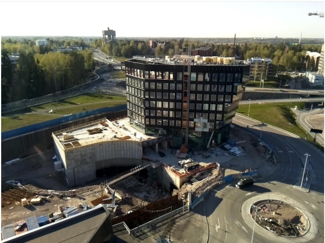
Kuva 1. Keilaniemi Next, työmaa
