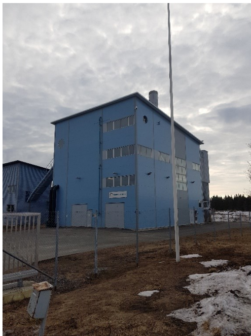
Kuva 3 Tornion Voima Oy:n Pirkkiön KPA-kattilalaitos
