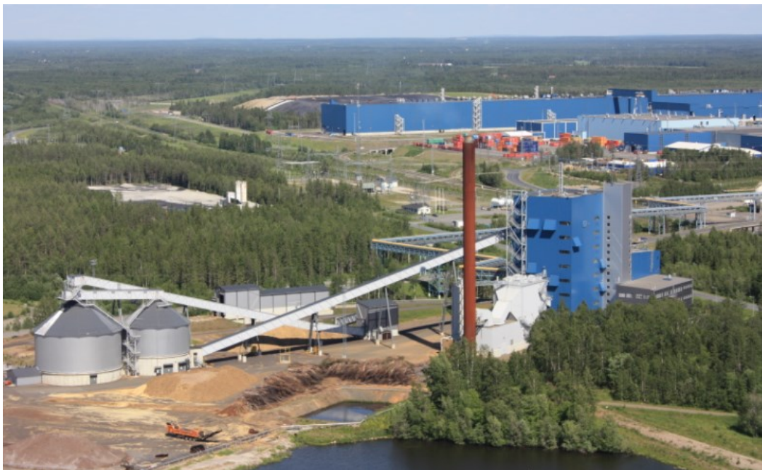
Kuva 2 Tornion Voima Oy:n CHP-voimalaitos (Tornion Voima 2022)
