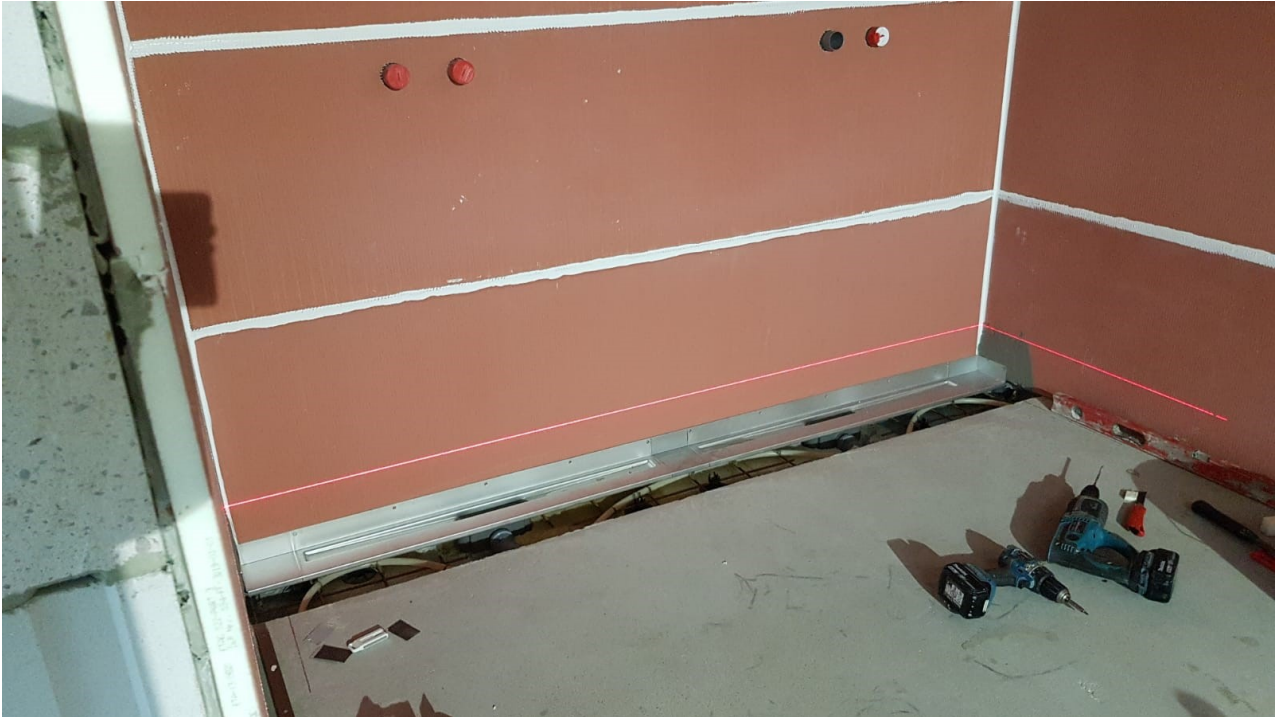
Kuva 14. Asennetut märkätilalevyt sekä linjalattiakaivo kolmella seinälaipalla.
