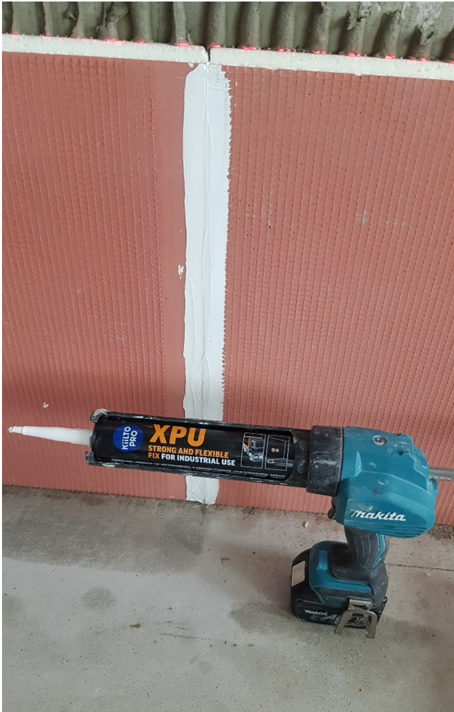
Kuva 13. Vedeneristelevyn pystysauman saumaus liimamassalla.
