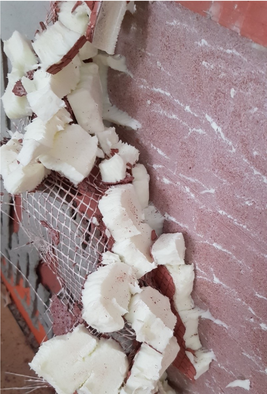
Kuva 19. Laatat piikattiin irti umpisolulevystä, jonka jälkeen laasti ja polystyreeni irroitettiin alustasta.
