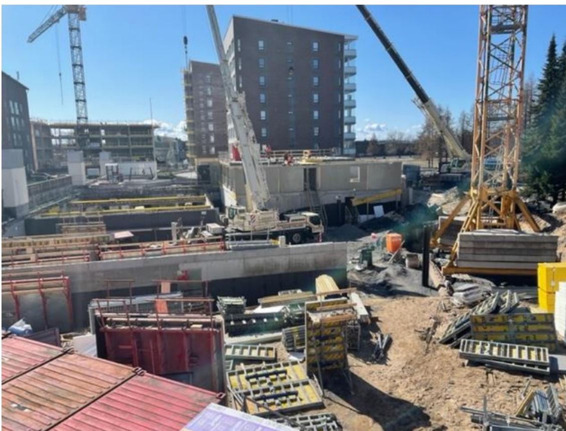
KUVA 4. As.oy. Oulun Piirto työmaa
