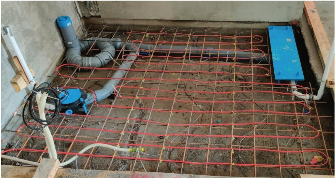
Kuva 1. Lämmityskaapelin asennus lattiaraudoitukseen.
