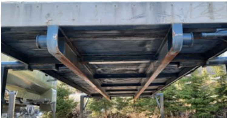
Kuva 4 Lavajuoksut ja niiden väliin jäävä tunneli.
