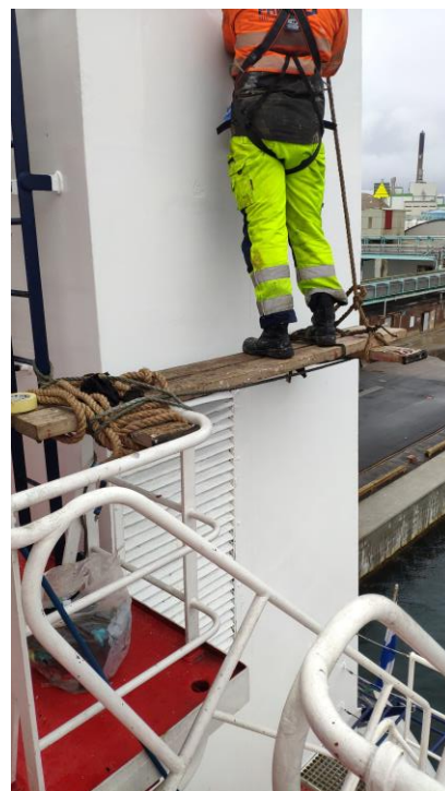
Bild 9 Användning av båtsmansstol samt säkerhetssele.
