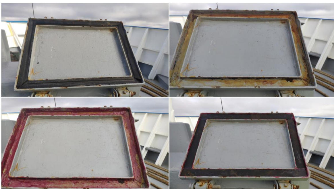
Bild 6 Bildserie av arbetsprocessen av tätnings byte på en fläkt lucka.
