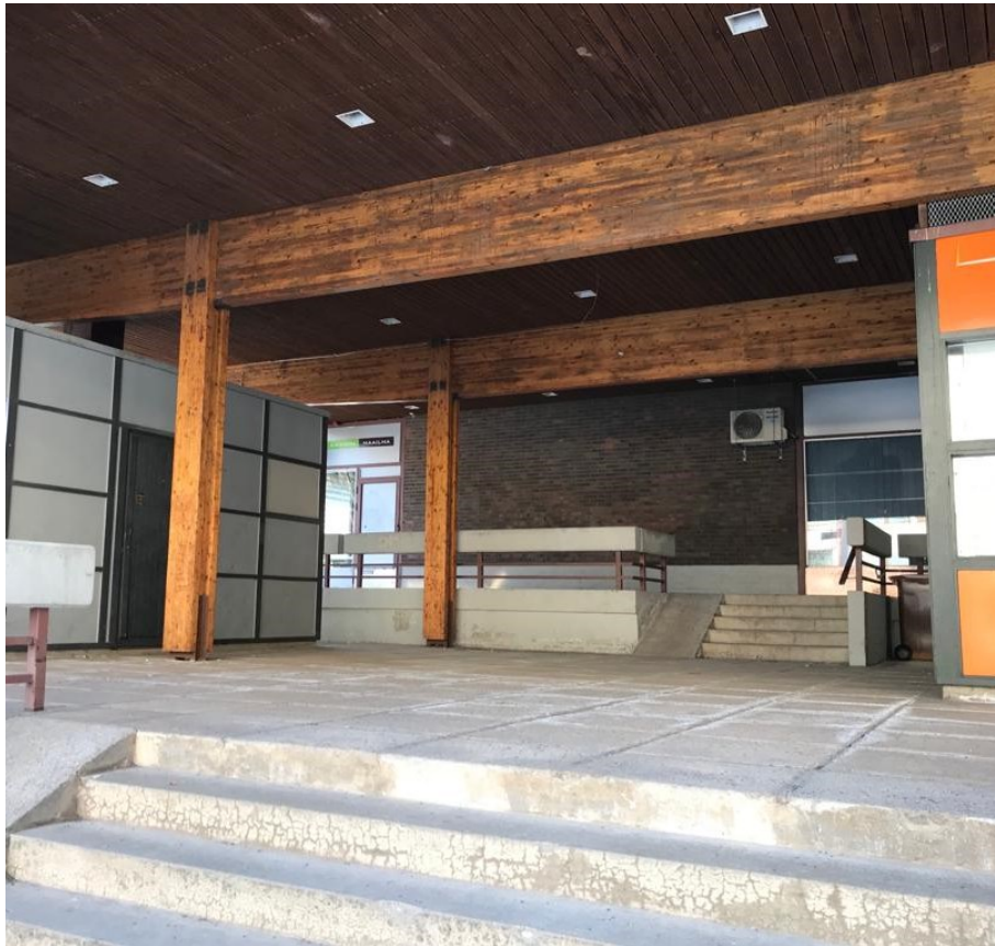
Kuva 11 Liimapuupilarit kannattavat massiivisia palkkeja. Näyttävä jalankulkuterassi toimii välittävänä tilana Kuohuaukion ja sisätilojen välillä.
