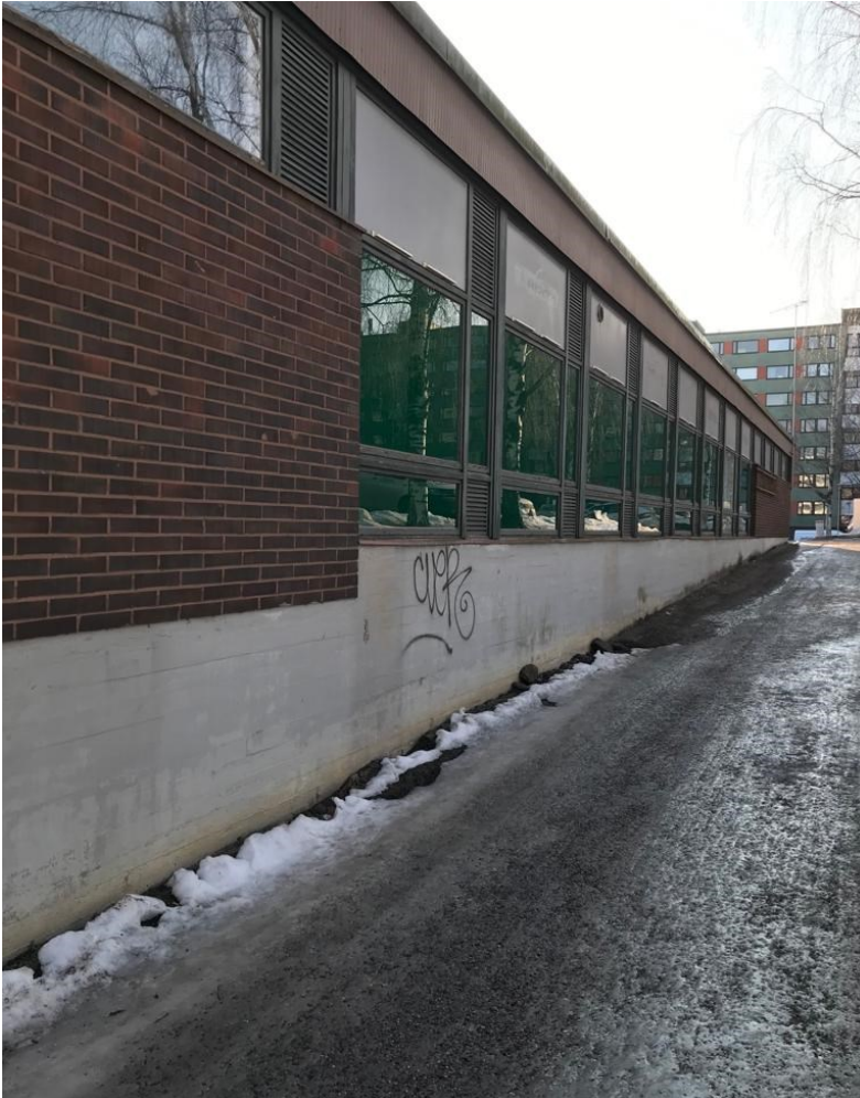
Kuva 17 Julkisivun tiilipinta ja pohjoisen puuikkunat
