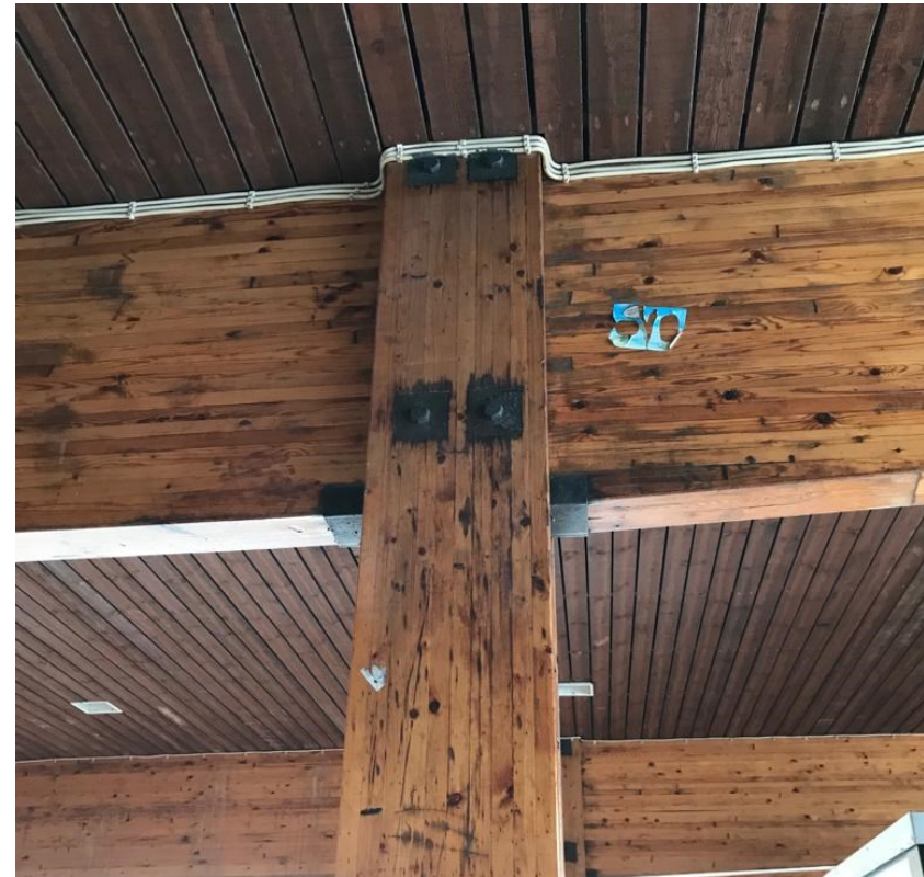
Kuva 14 Pilarin ja palkin liitos
