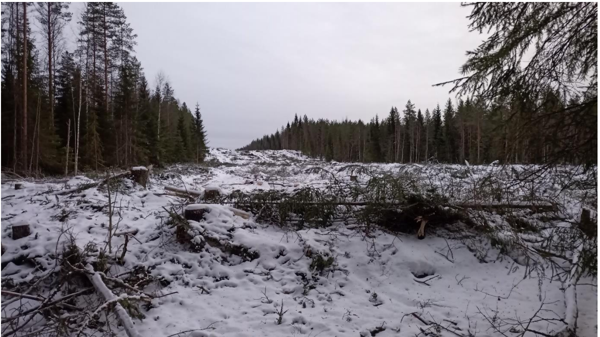
Kuva 5. Valmiiksi hakattu 110 kV voimalinja.
