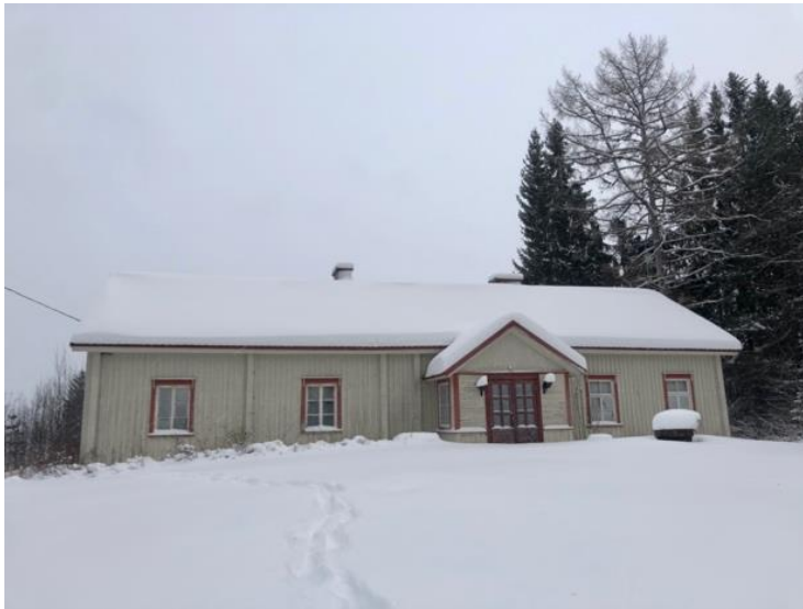
KUVA 8. 1800-luvulla rakennettu päärakennus. (Kiiskinen)
