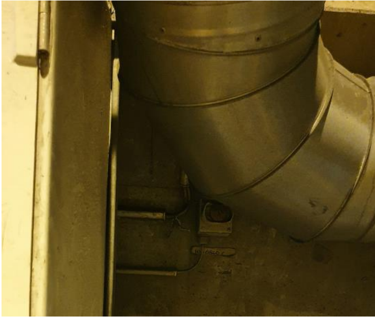
Kuva 23. Hätäseis-painike autoklaavin tasolla putken takana
