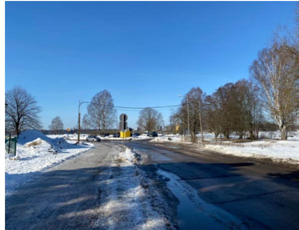
Lähestyminen suunnittelualueelle Hiekkarannantietä idästä tultaessa.
