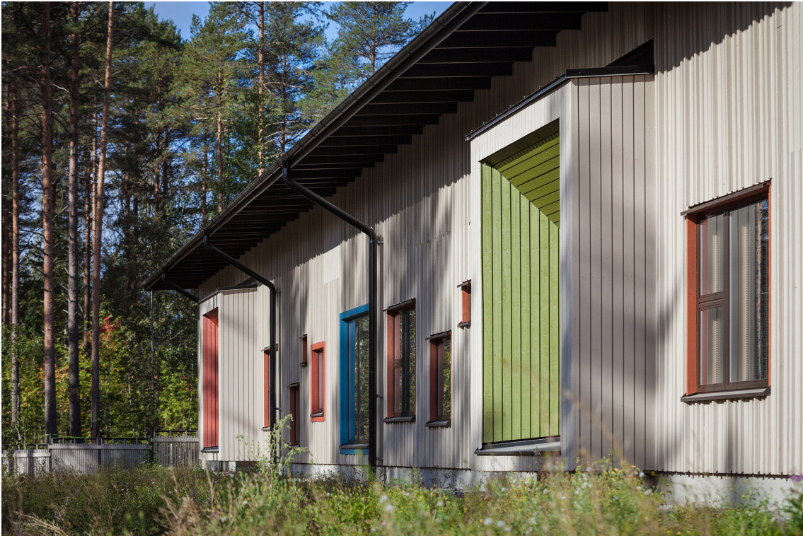
KUVA 18. Satavuon ekologisen puukoulun räystäät luovat varjostusta rakennuksen julkisivulle (45.)
