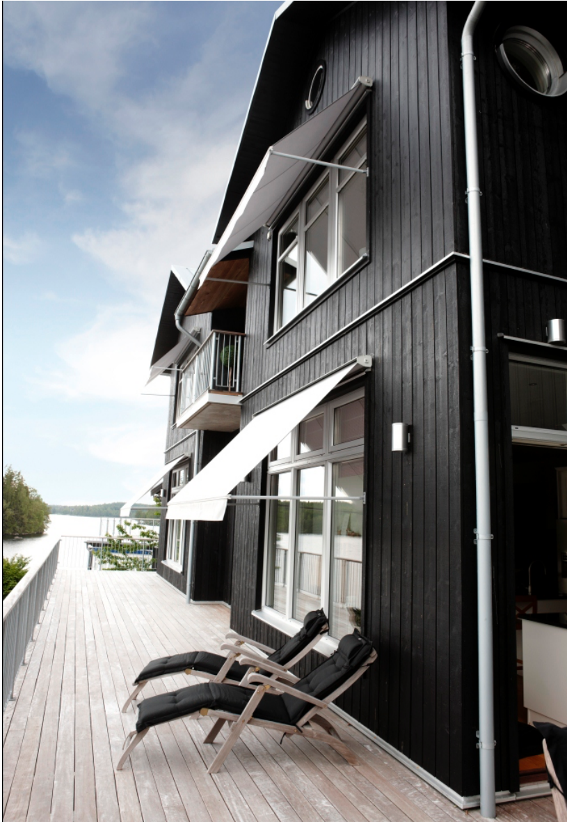
KUVA 23. Markiisit suojaavat ikkunoita tehokkaasti auringonsäteilyltä (60).
